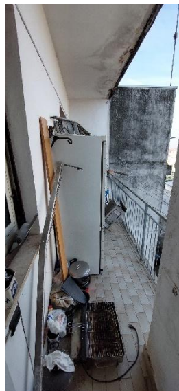
FOTO 16 – Balcone cucina lato cortile
