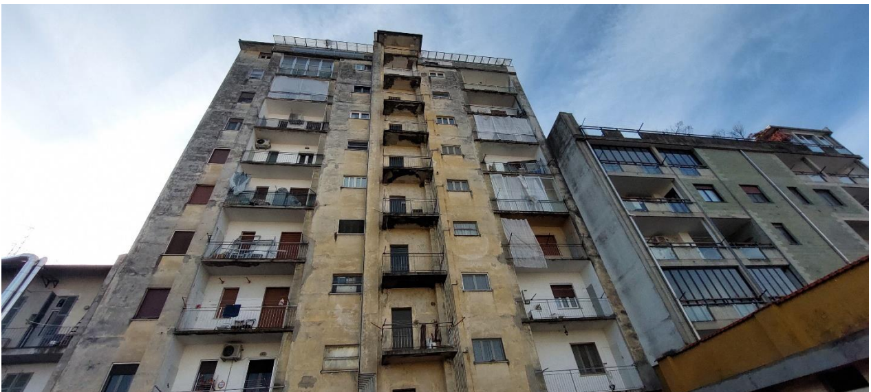
FOTO 6 – Facciata su cortile interno
