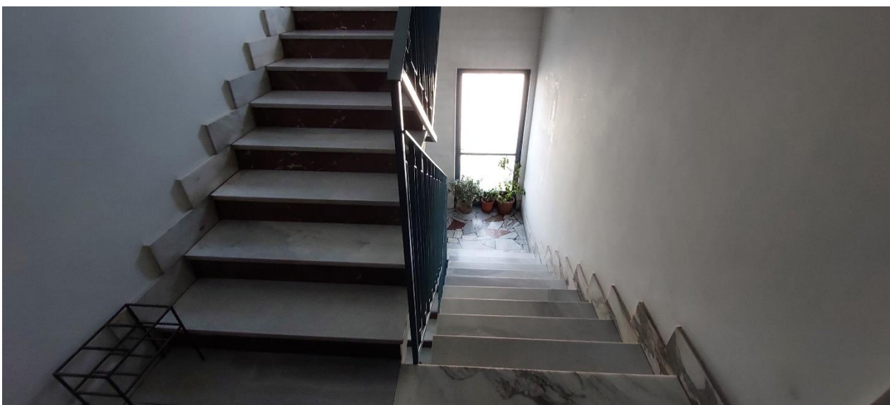
FOTO 8 – Vano scala condominiale
