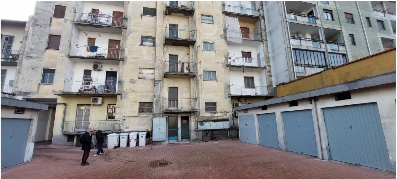
FOTO 5 – Facciata su cortile interno
