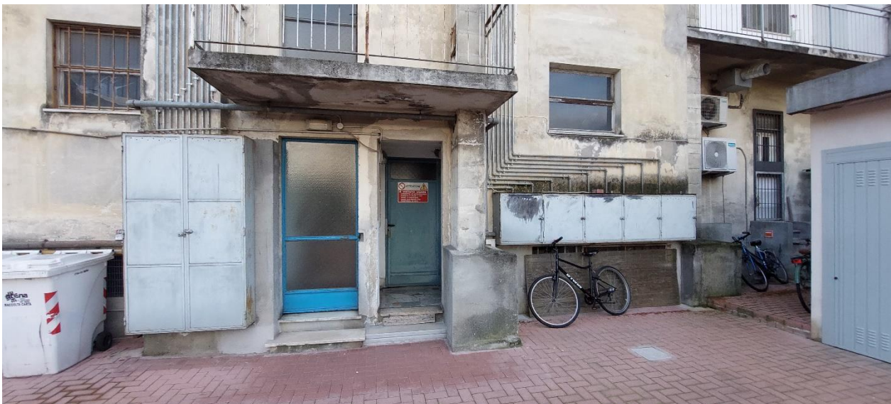
FOTO 7 – Accesso al vano scala e alle cantine
