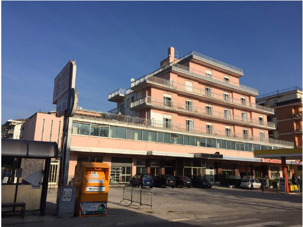
Foto 1: Prospetto Sud su Via Salaria
