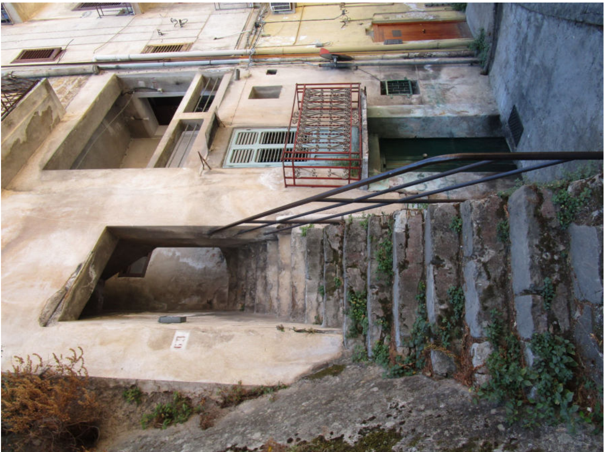
Foto 2 – Scala di accesso alla palazzina
