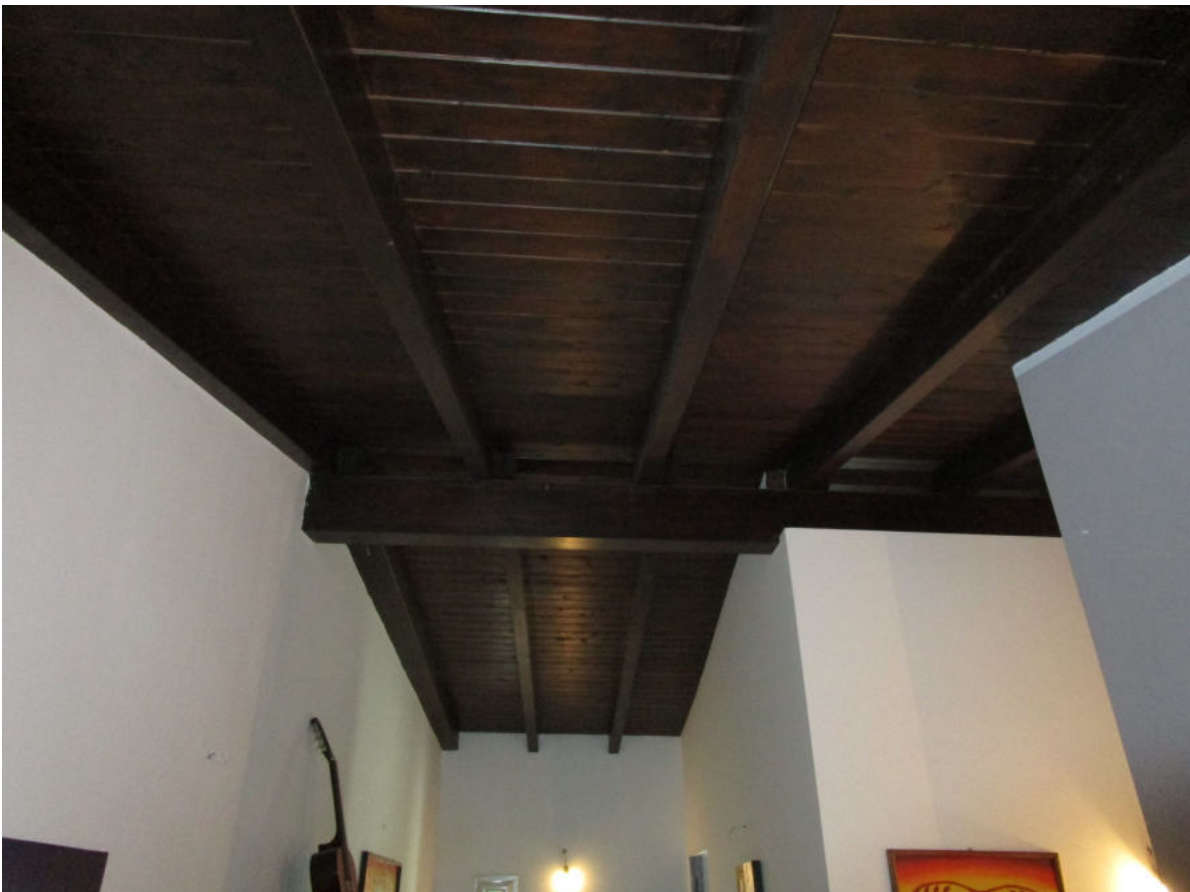
Foto 14 – Particolare della struttura della copertura
