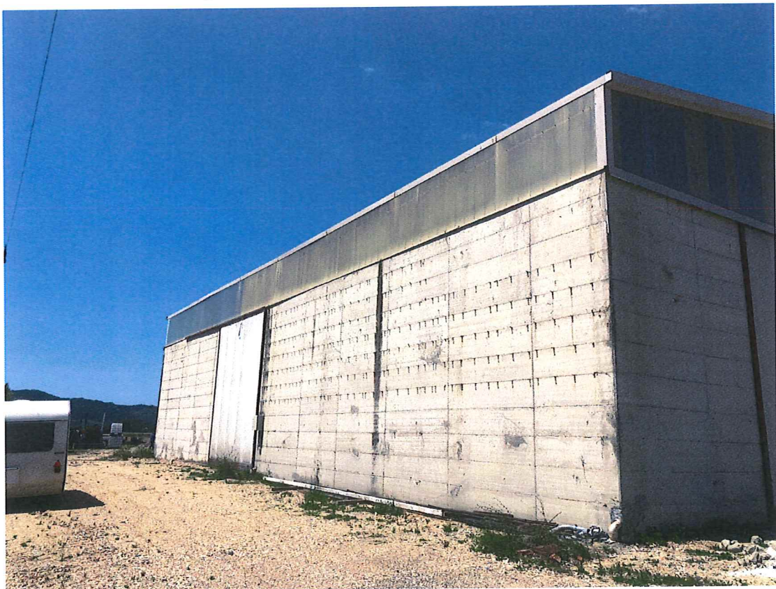
Foto n. 8 – Bettona. Come foto n. 7.
