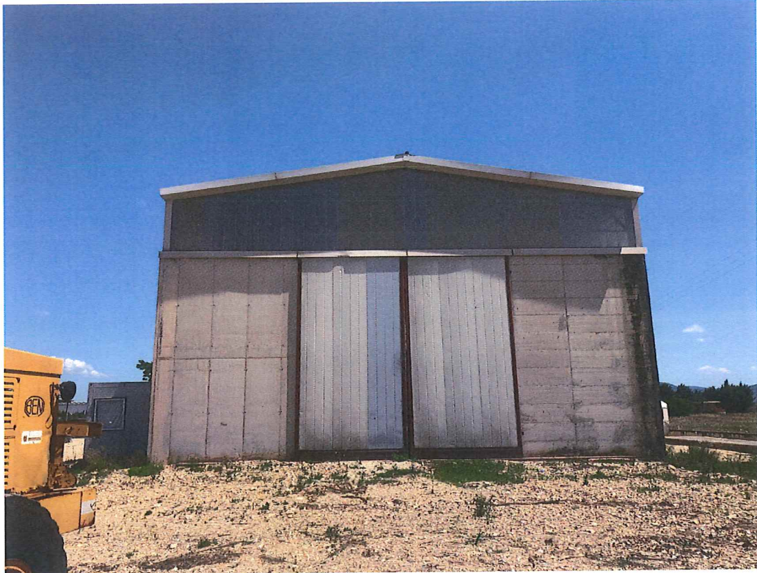
Foto n. 3 – Bettona. Come foto n. 2.
