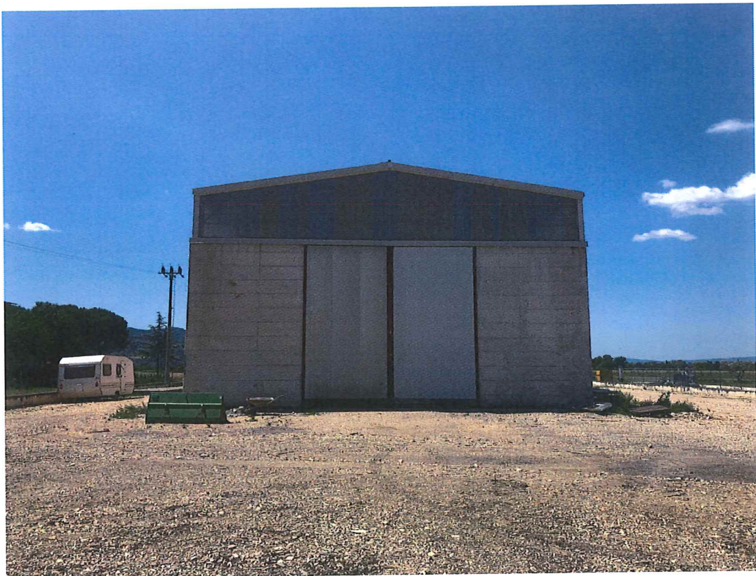
Foto n. 6 – Bettona. Retrospetto (nord-est).
