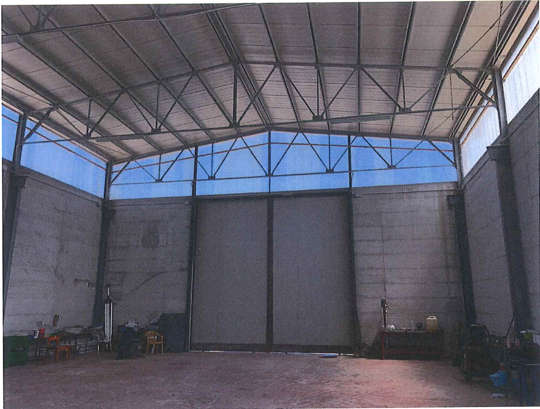
Foto n. 11 – Bettona. Interno capannone: particolari strutture.
