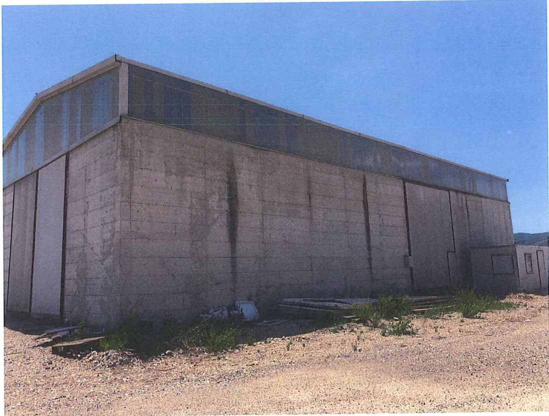
Foto n. 5 – Bettona. Come foto n. 4.
