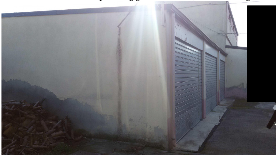
Foto 3 – Accesso al magazzino, dotato di tre saracinesche, dalla Part. 587 (passaggio comune) che collega alla S.S. 121.
