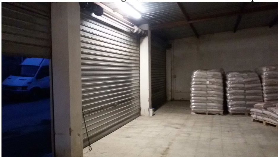
Foto 4 – Interno del magazzino con vista della copertura metallica
