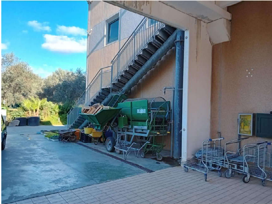
SCALA ANTINCENDIO AL PIANO PRIMO
