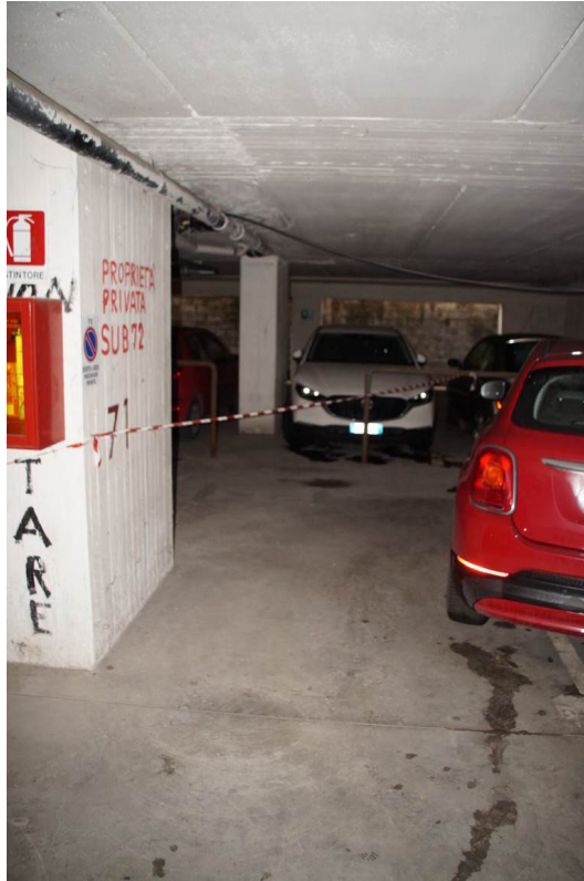
Foto n°17: particolare del posto auto posizionato al piano primo sottostrada.
