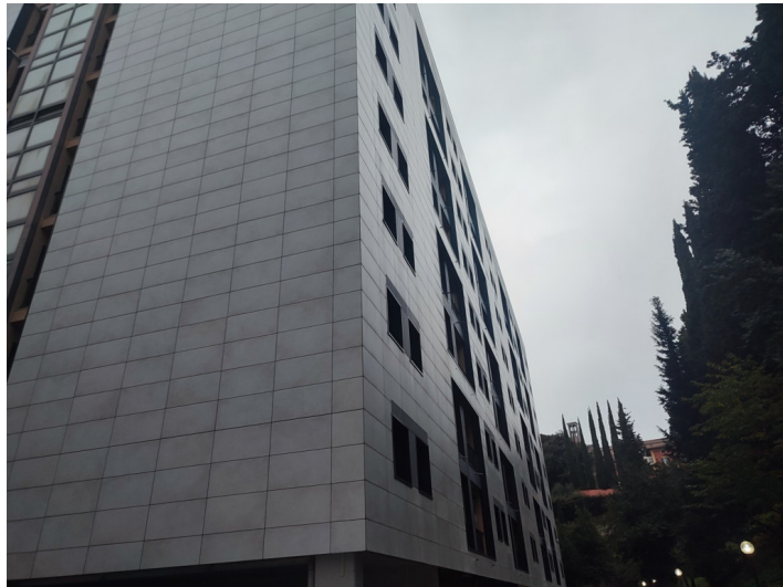
Foto n°2: vista lato Sud-Est dell'edificio.
