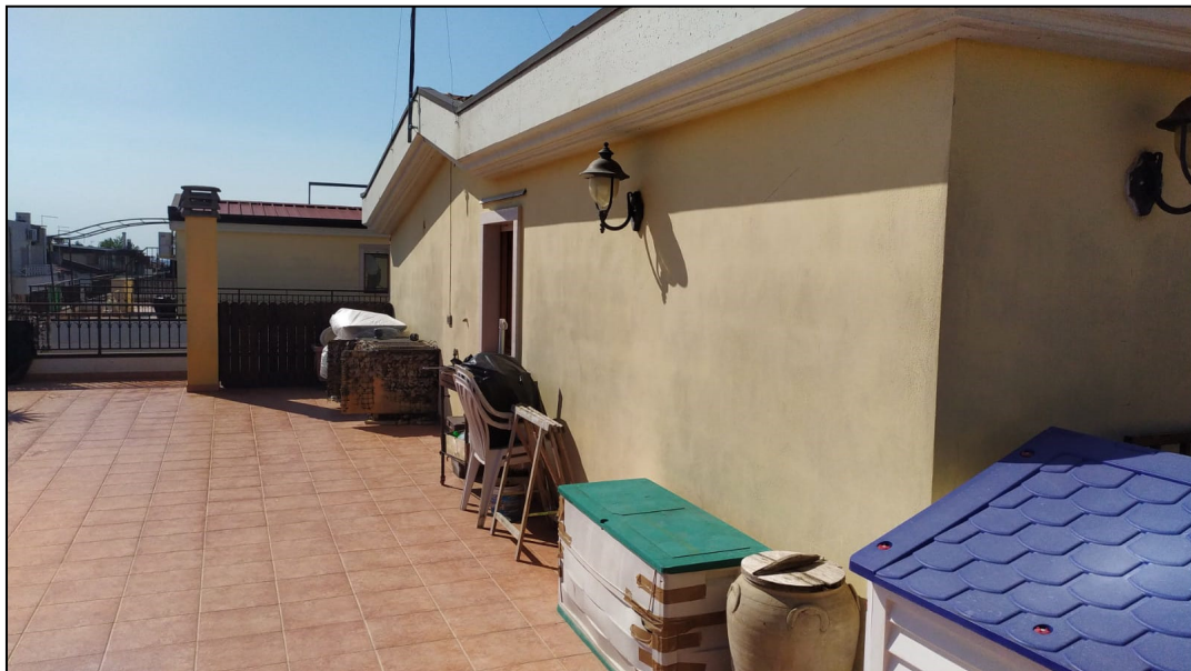
Foto 12: Vista esterna terrazzo al terzo piano
