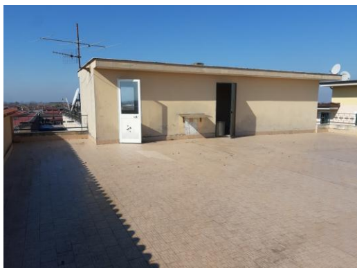
lastrico solare parte 1
