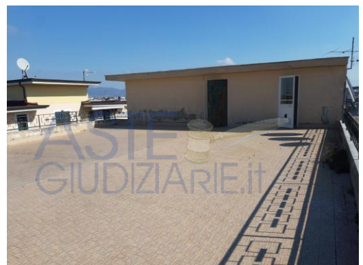
lastrico solare parte 2
