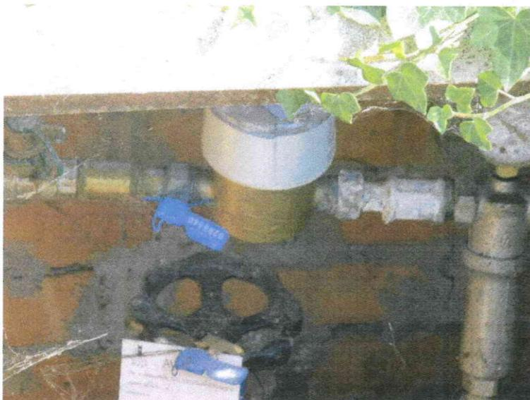
Foto 39 – Esterno – Particolare Contatore Utenza Acqua e Antincendio.
