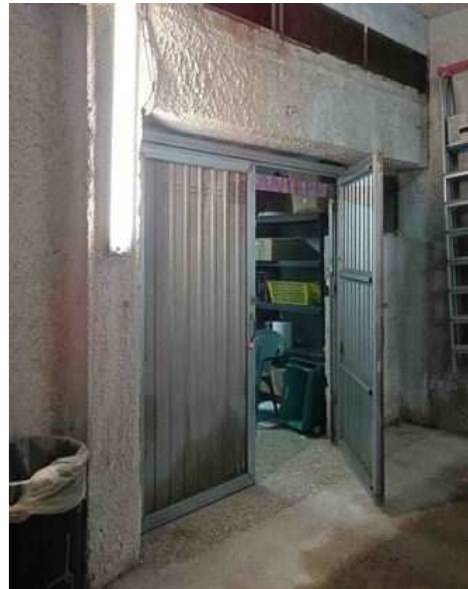
Vista box auto - esterno
