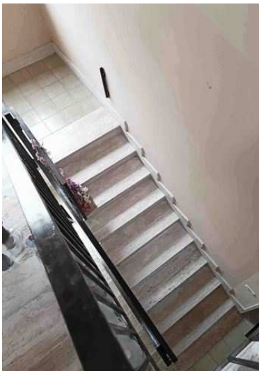
Vista Scala A - Rampe
