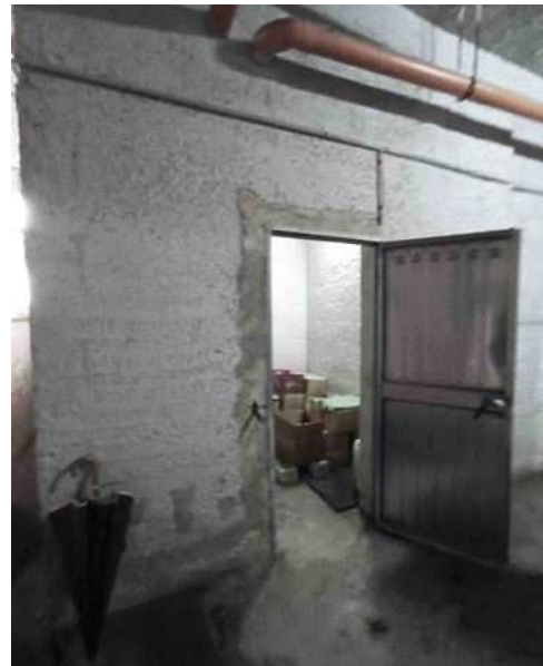
Vista della cantinola - esterno
