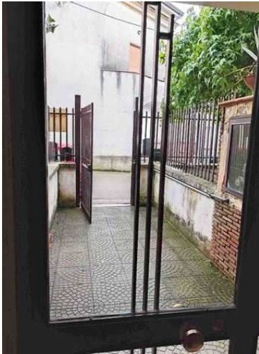
Vista Scala A - Ingresso
