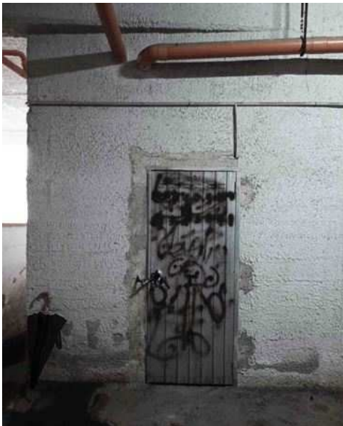
Vista della cantinola - esterno
