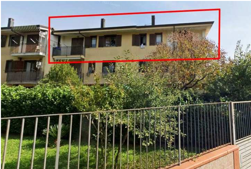
Vista dall'esterno - lato ovest
