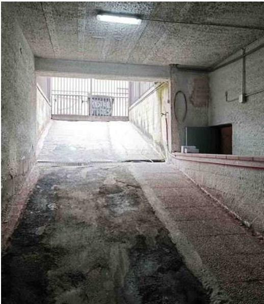
Vista della rampa di accesso al Seminterrato
