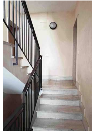
Vista Scala A - Rampe
