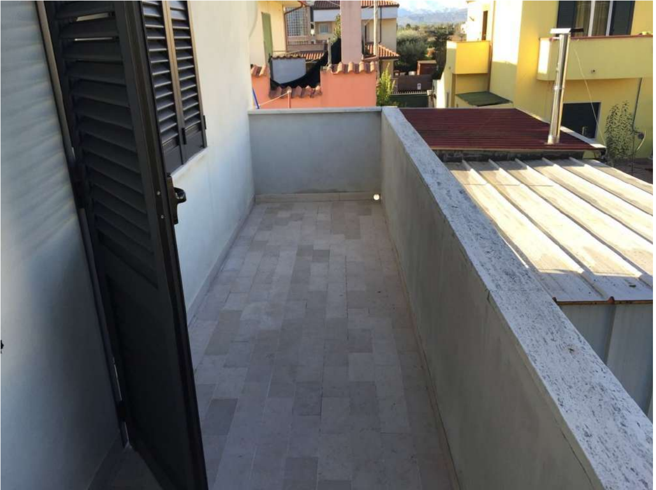
Foto 13 – Balcone lato Nord Piano Primo
