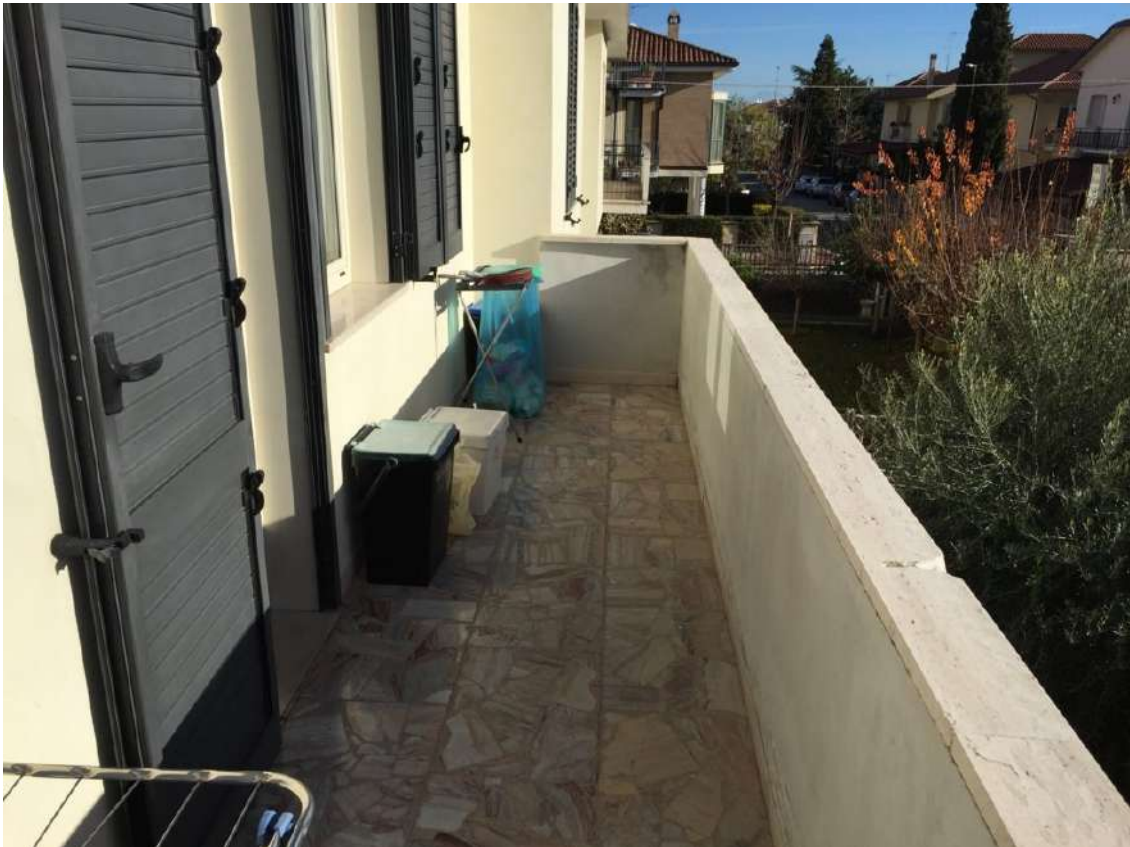
Foto 12 – Balcone lato sud Piano Primo
