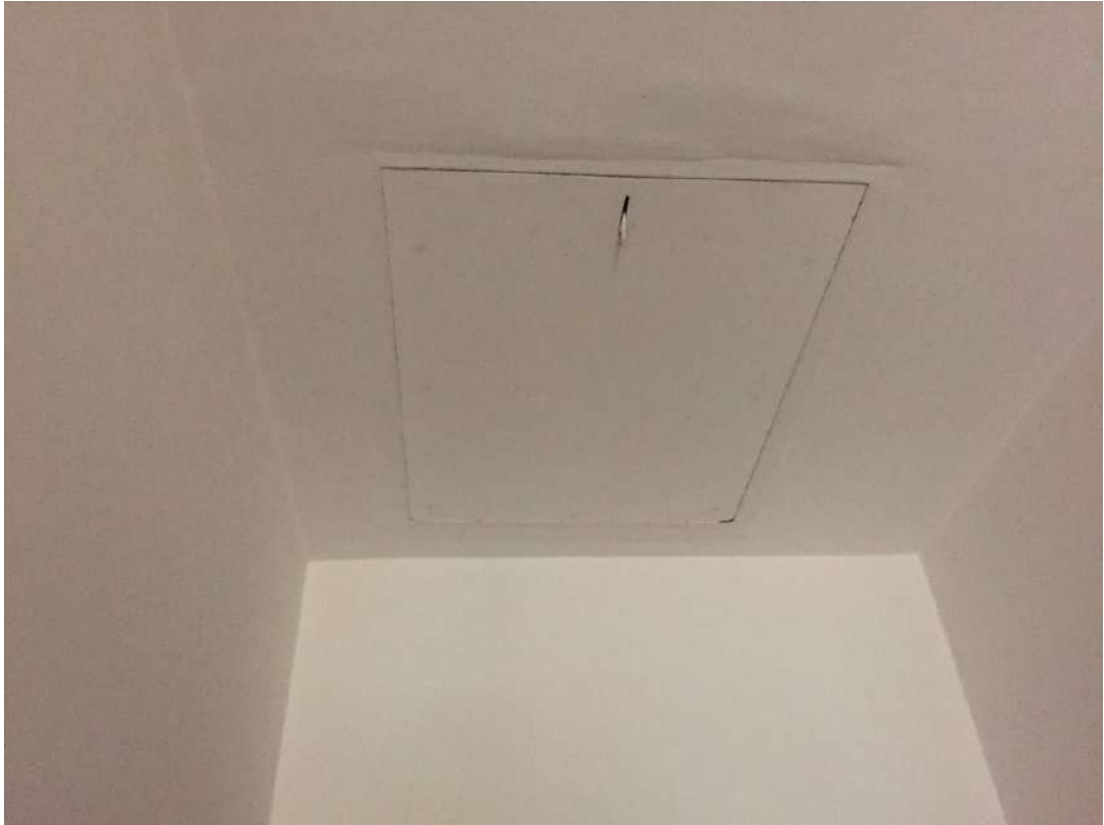
Foto 11 – Botola di accesso al Piano Sottotetto
