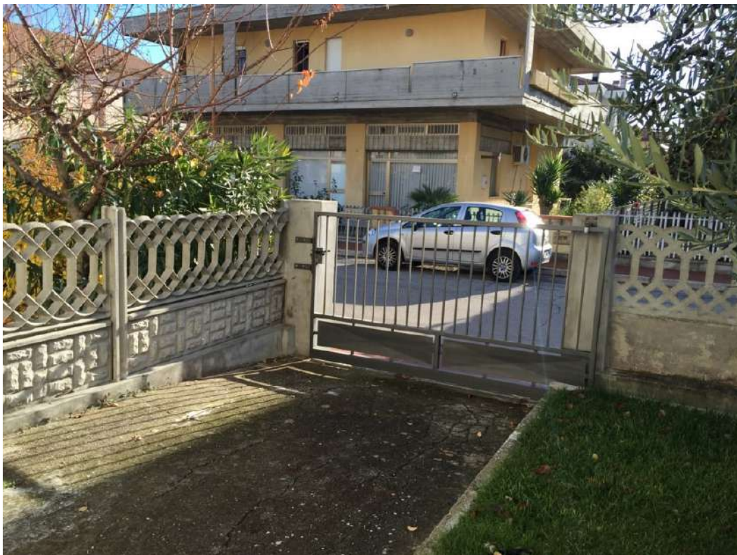
Foto 16 – Particolare accesso carrabile Piano Terra
