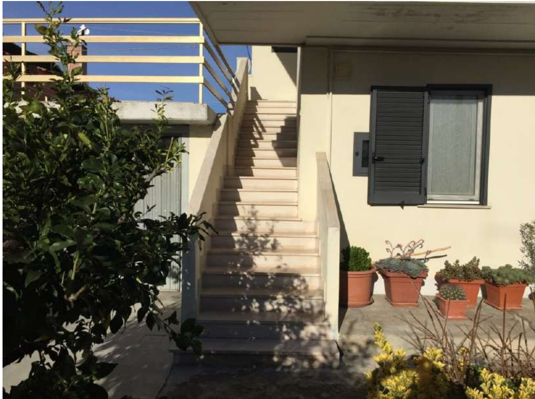
Foto 02 – Scala di accesso al Piano Primo
