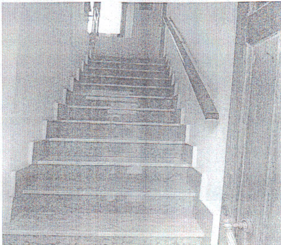
SCALA DI ACCESSO
