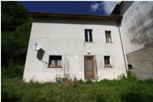
retro con accesso al piano seminterrato ora utilizzato come principale
