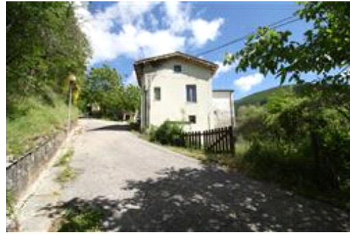
fianco destro, con strada che conduce al fabbricato
