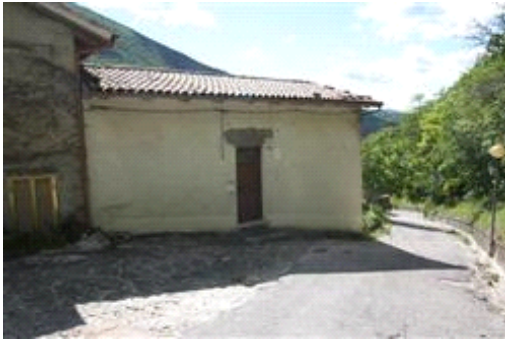
accesso principale al piano terra ora utilizzato come reparto notte
