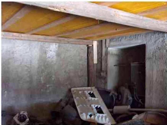
Foto n.° 5: Interno autorimessa
