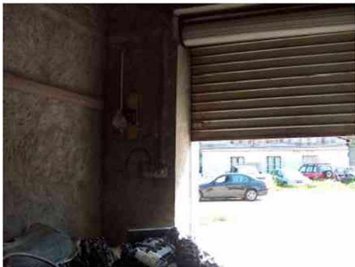
Foto n.° 6: Interno autorimessa
