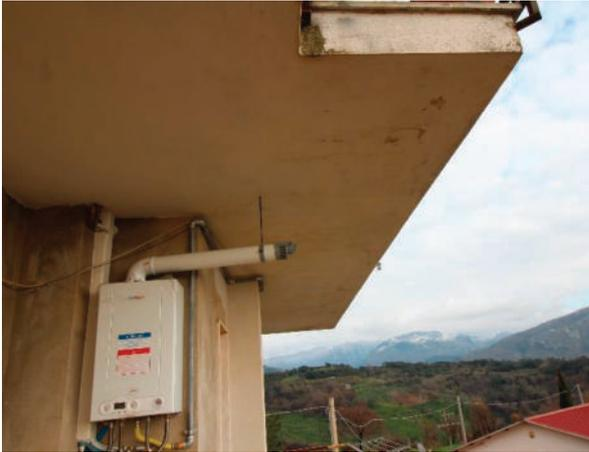
Foto 7: Particolare balconi con infiltrazioni d'acqua
