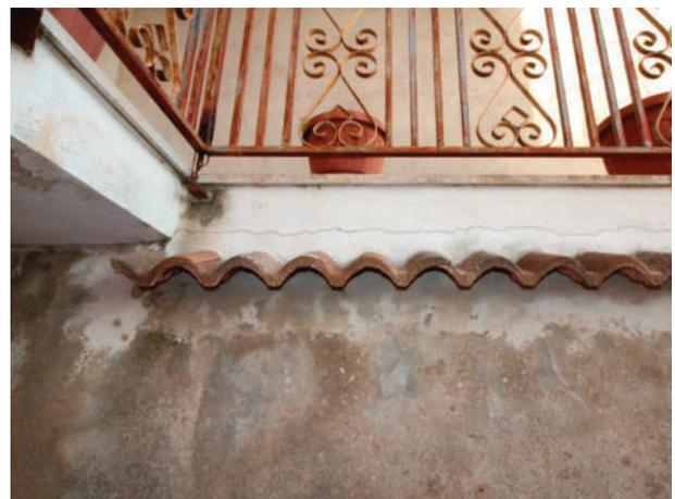
*Foto 6: Particolare montante ringhiera completamente corrosso dalla ruggine*
