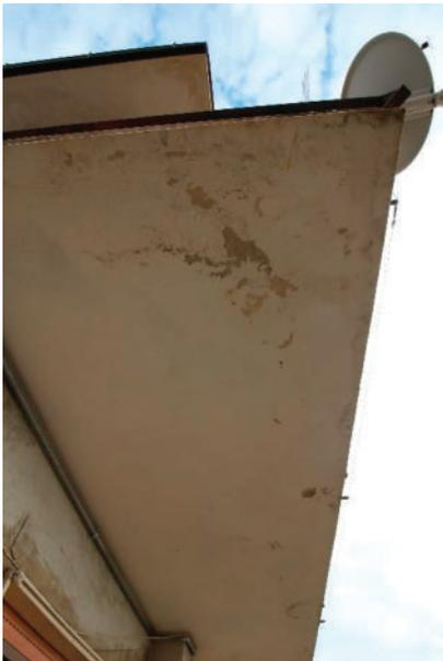
Foto 9: Particolare balconi con infiltrazioni d'acqua
