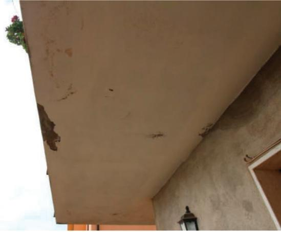
Foto 8: Particolare balconi con infiltrazioni d'acqua
