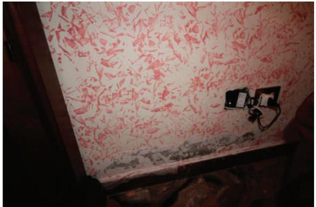
*Foto 30: Particolare umidità ed impianto elettrico soggiorno*
