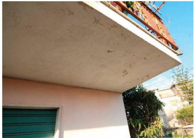
Foto 10: Particolare balconi con infiltrazioni d'acqua
