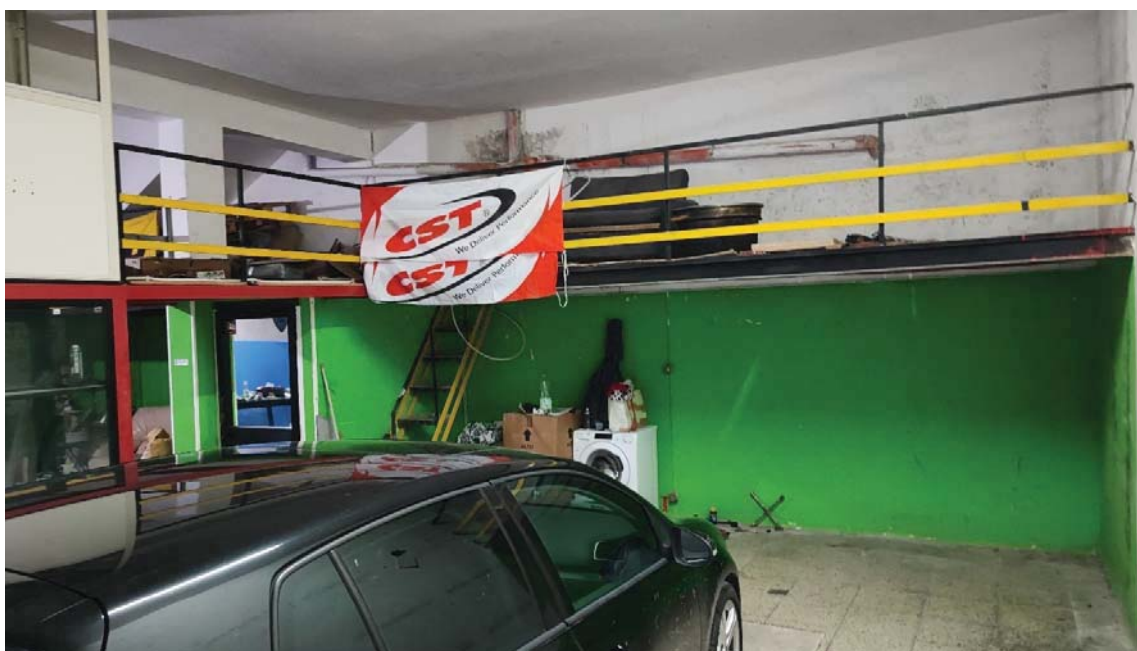
Figure 5 – Vano principale PT e soppalco
