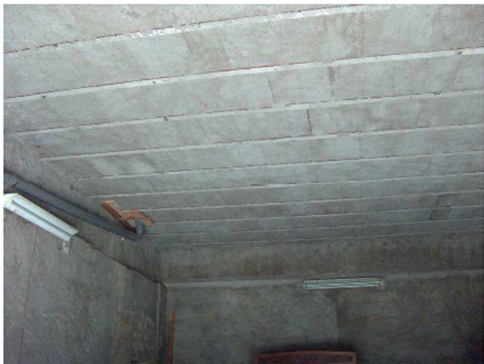
Foto n.° 7: Interno autorimes:a.
