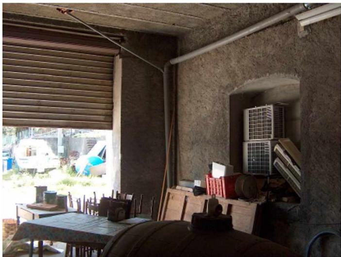
Foto n.° 8: Interno autorimes:a.
