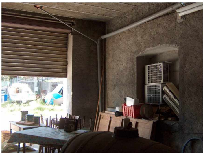
Foto n.° 8: Interno autorimes:a.
