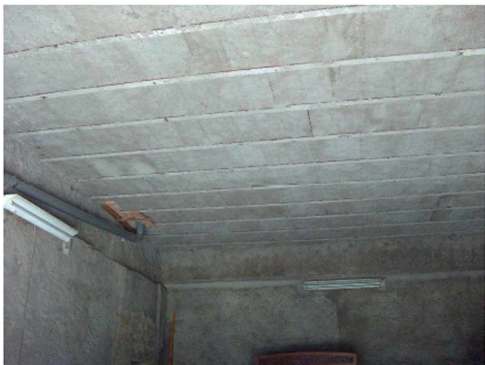
Foto n.° 7: Interno autorimes:a.
