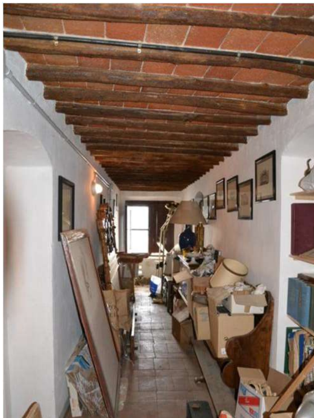
FOTO 6: locali deposito piano ammezzato
