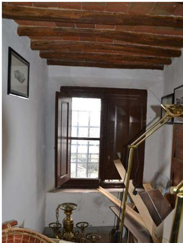
FOTO 7: locali deposito piano ammezzato
