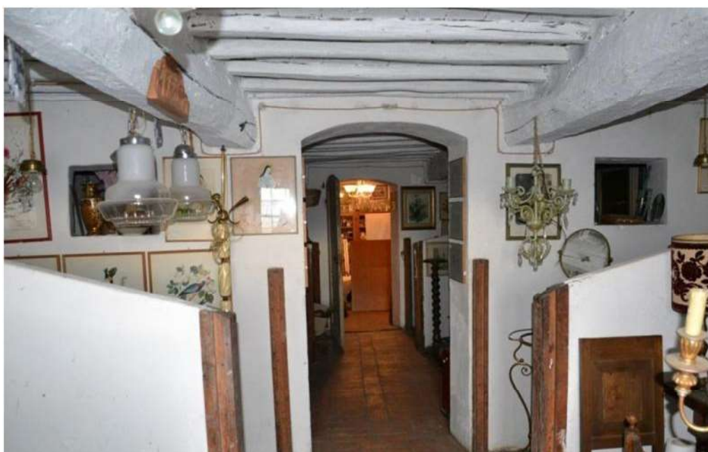
FOTO 4: locali deposito piano ammezzato
