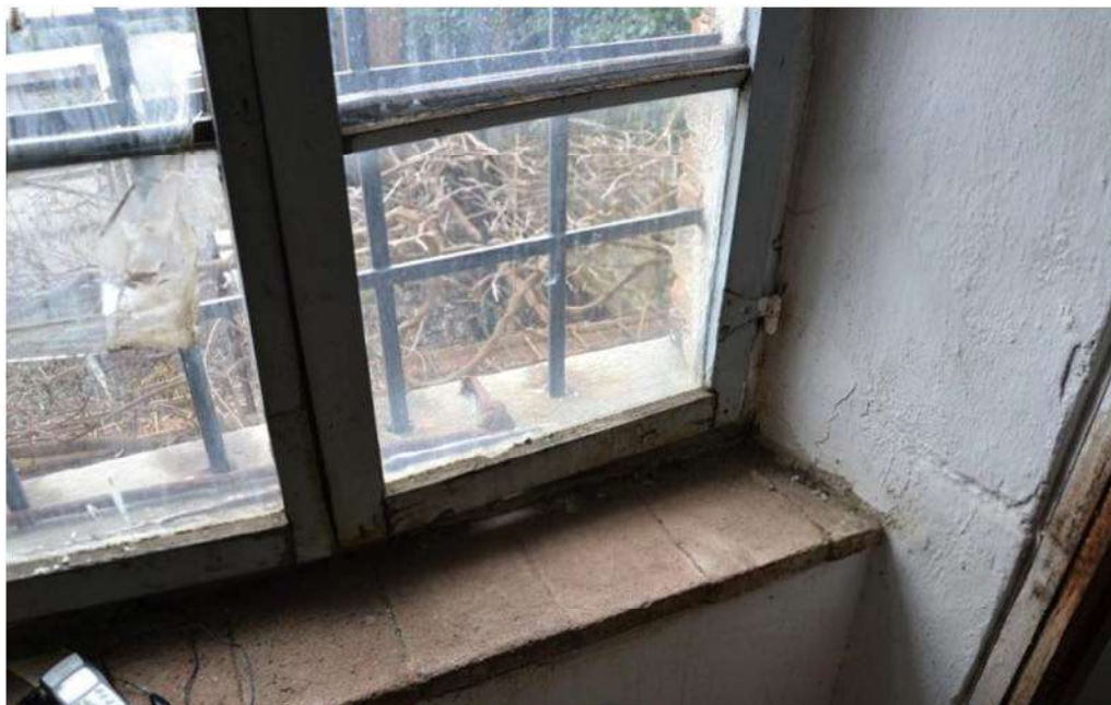
FOTO 3: locali deposito piano ammezzato
