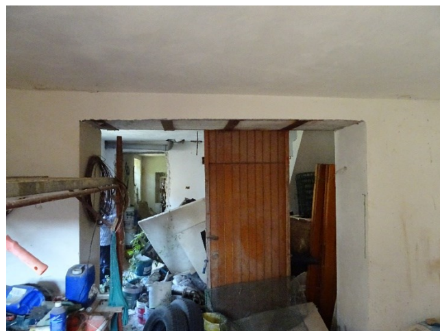
Sub.4 Abitaz.: Piano T – Cucina (vista verso ingresso)
