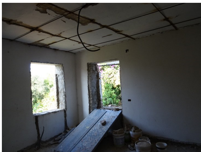
Sub.4 Abitaz.: Piano 1° – Camera lato N-E
