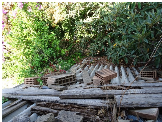
Sub.3 Rimessa: copertura, vista da P1
