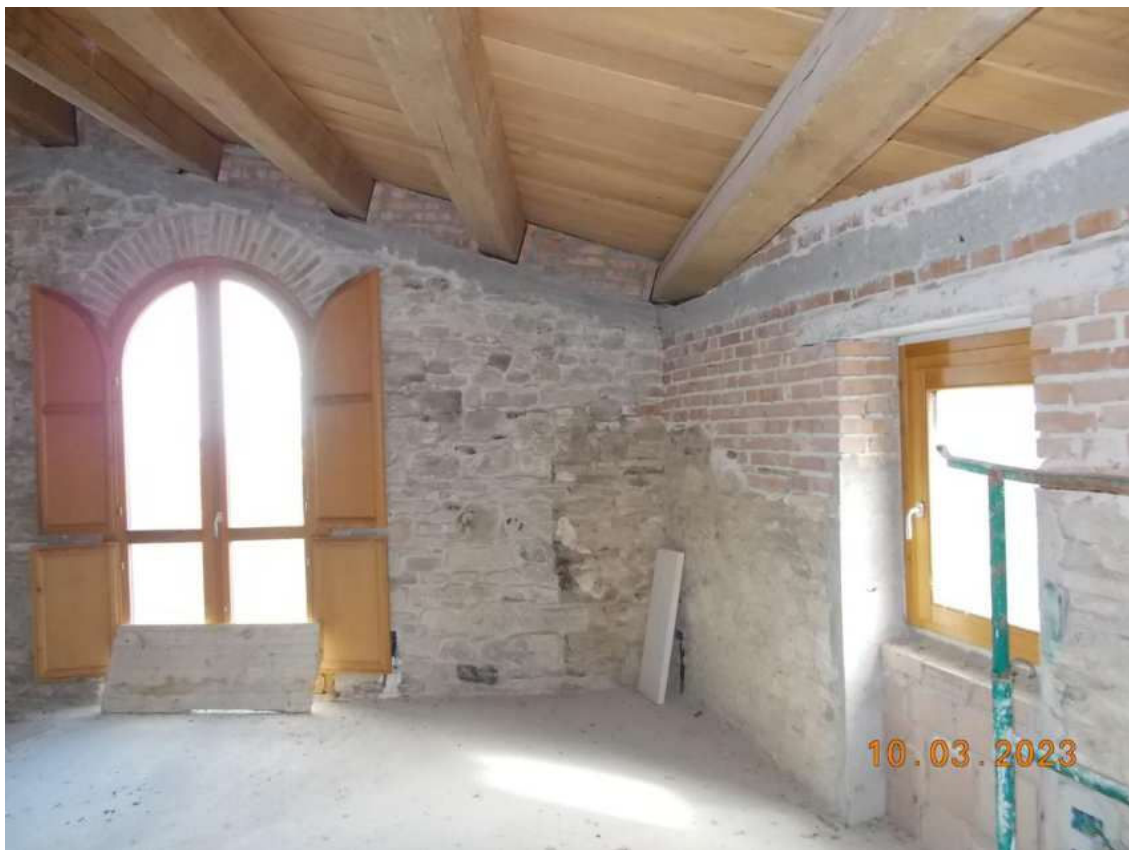
Foto 42-43 - - Albergo al P.T. – Stanze non ultimate - Fg 4 p.IIa 297 sub 16
