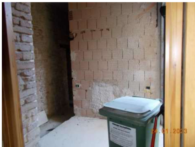
Foto 15 -16 -17 – Centro Benessere al piano S1 - Fg 4 p.lla 297 sub 14
