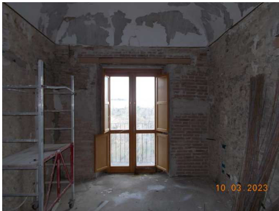
Foto 36-37 - Albergo al P.T. – Stanze non ultimate - Fg 4 p.IIa 297 sub 16
