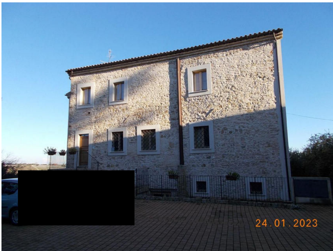
Foto 1 e 2 – Esterni lato piazzetta e lato strada
