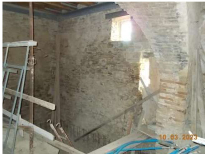
Foto 21 – 22 - 23 – Centro Benessere al piano S1 - Fg 4 p.la 297 sub 14
