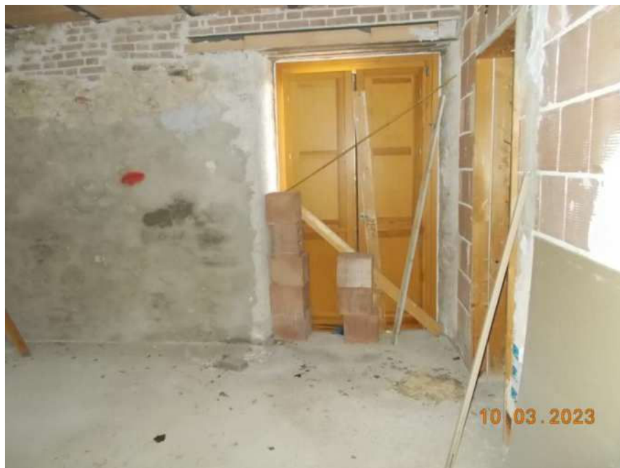
Foto 38-39 - Albergo al P.T. – Stanze non ultimate - Fg 4 p.IIa 297 sub 16
