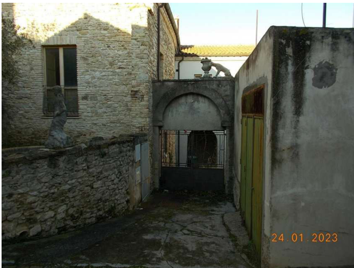
Foto 3 e 4 – Esterni cortile secondario lato strada
