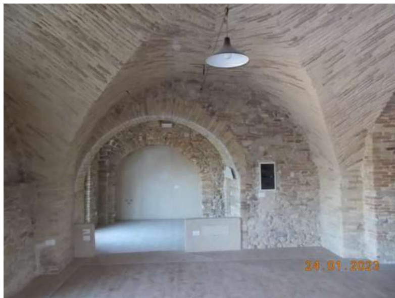
Foto 24 – 25 - 26 – Ristorante al piano S1 - Fg 4 p.la 297 sub 15
