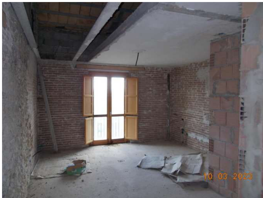
Foto 40-41 - Albergo al P.T. – Stanze non ultimate - Fg 4 p.IIa 297 sub 16
