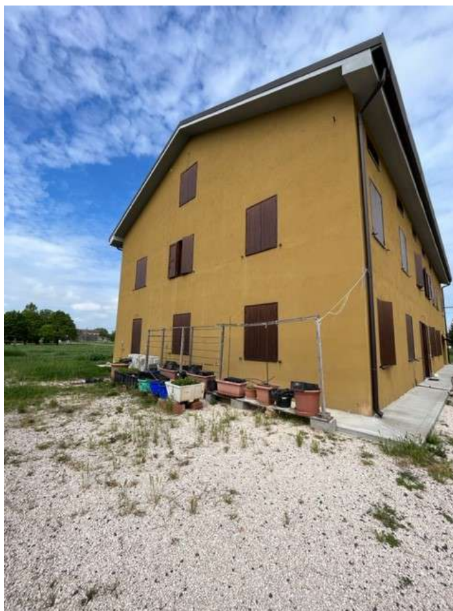
Fotografia 5 – Vista dell'immobile dal cortile
