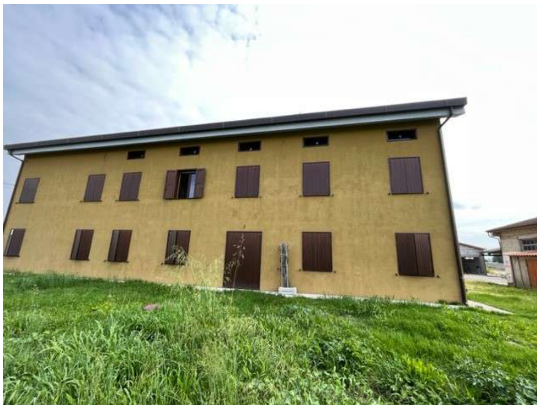
Fotografia 4 – Vista dal retro dell'immobile
