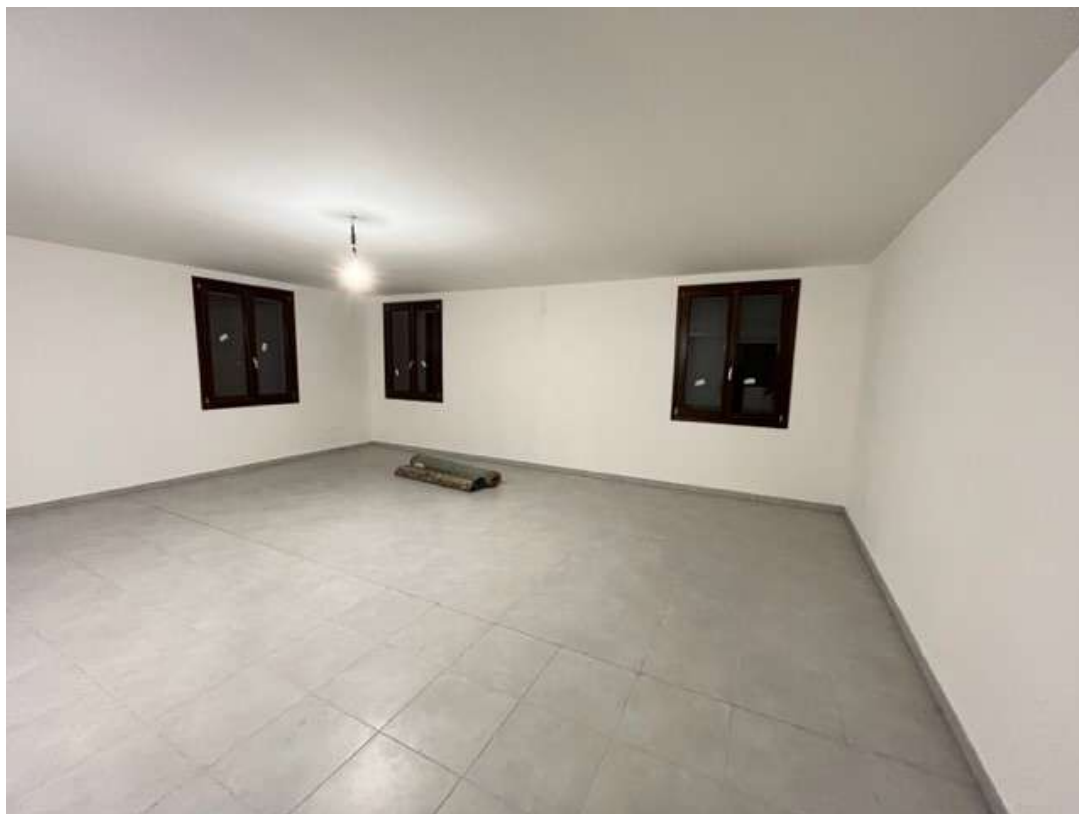
Fotografia 27- Vista del locale ripostiglio
