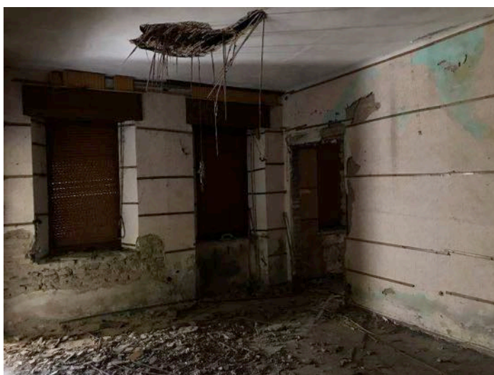
Lotto D edificio Solferino
