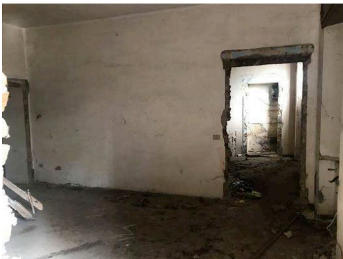
Lotto D edificio Solferino
