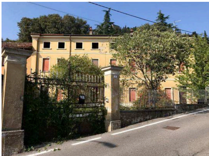
Lotto D edificio Solferino
