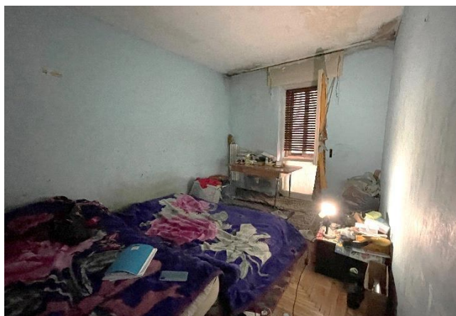
Vista della camera centrale
