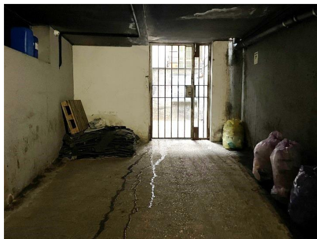
Vista dell'ex passaggio carrabile di accesso all'autorimessa
