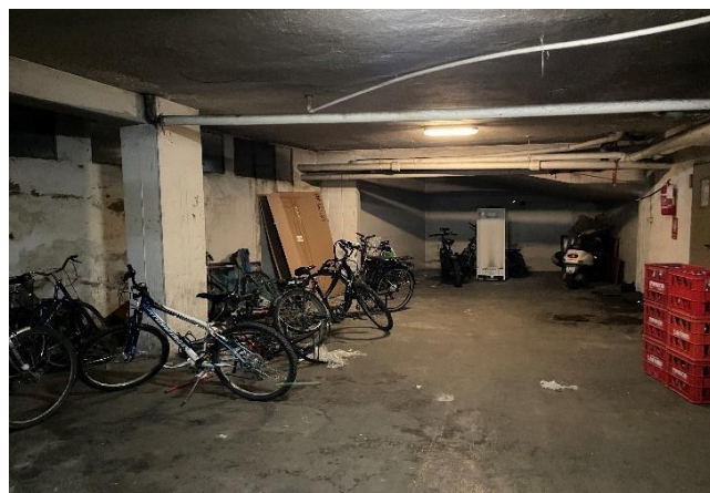
Vista della corsia dell'autorimessa interrata
