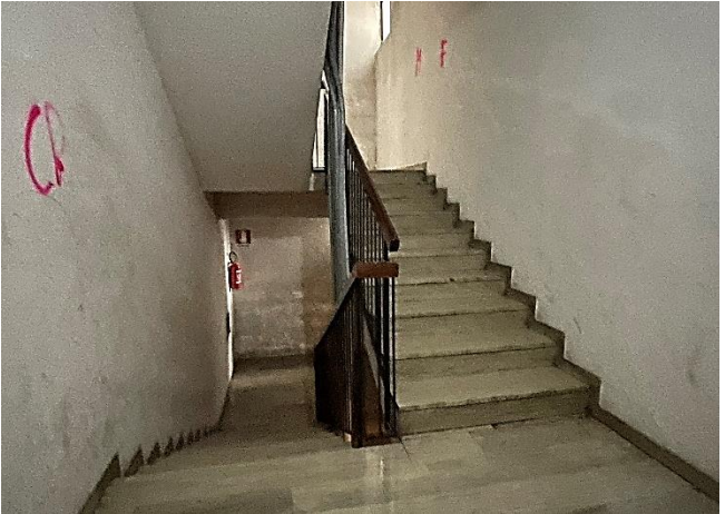
Vista vano scala condominiale
