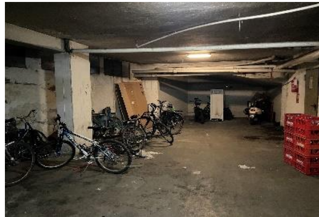
Vista della corsia dell'autorimessa interrata
