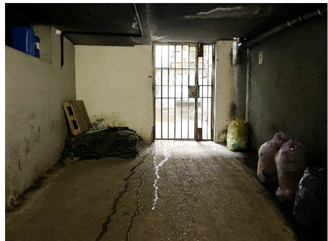
Vista dell'ex passaggio carrabile di accesso all'autorimessa
