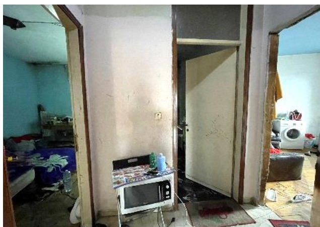
Vista del disimpegno
