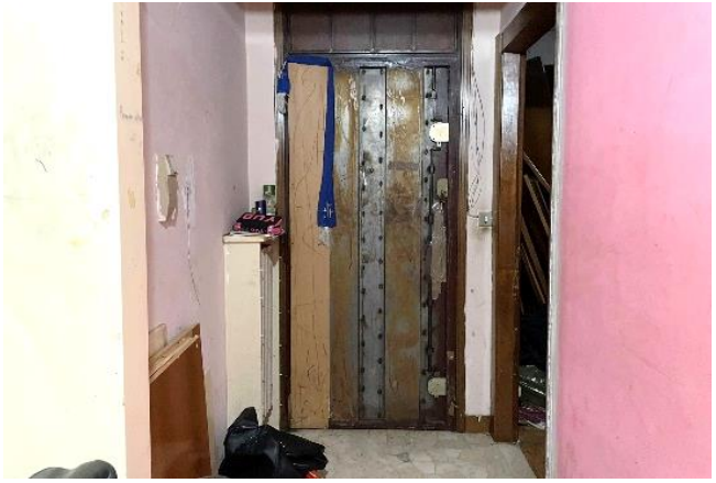
Vista dell'ingresso all'appartamento
