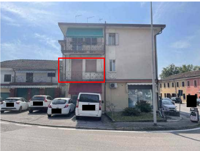
foto n. 3 – prospetto ovest fabbricato condominiale
