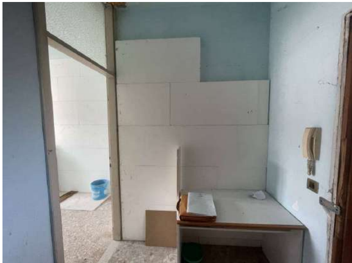
foto n. 13 – disimpegno tra entrata e zona notte
