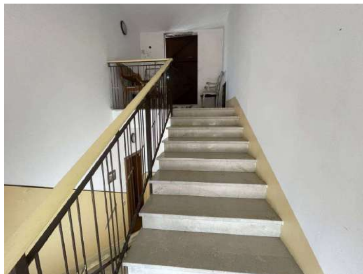
foto n. 22 – scala di accesso alla parte di copertura con tetto piano
