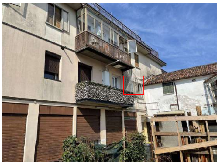
foto n. 6 – parte prospetto nord con individuazione appartamento
