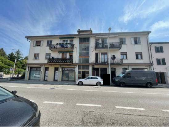
foto n. 1 – prospetto sud fabbricato condominiale
