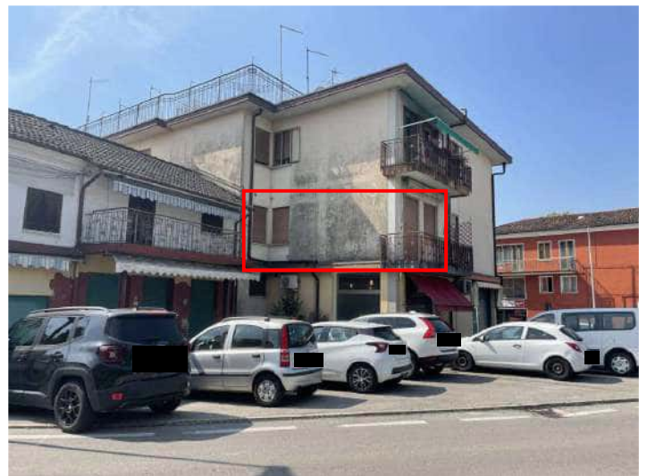
foto n. 4 – parte prospetto nord con individuazione appartamento
