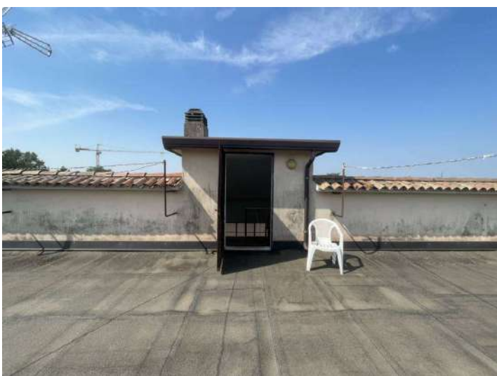
foto n. 23 – terrazza in copertura
