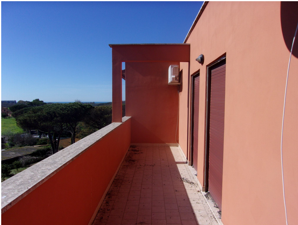
FOTO N. 12 Appartamento – Ripresa sul Terrazzo -
