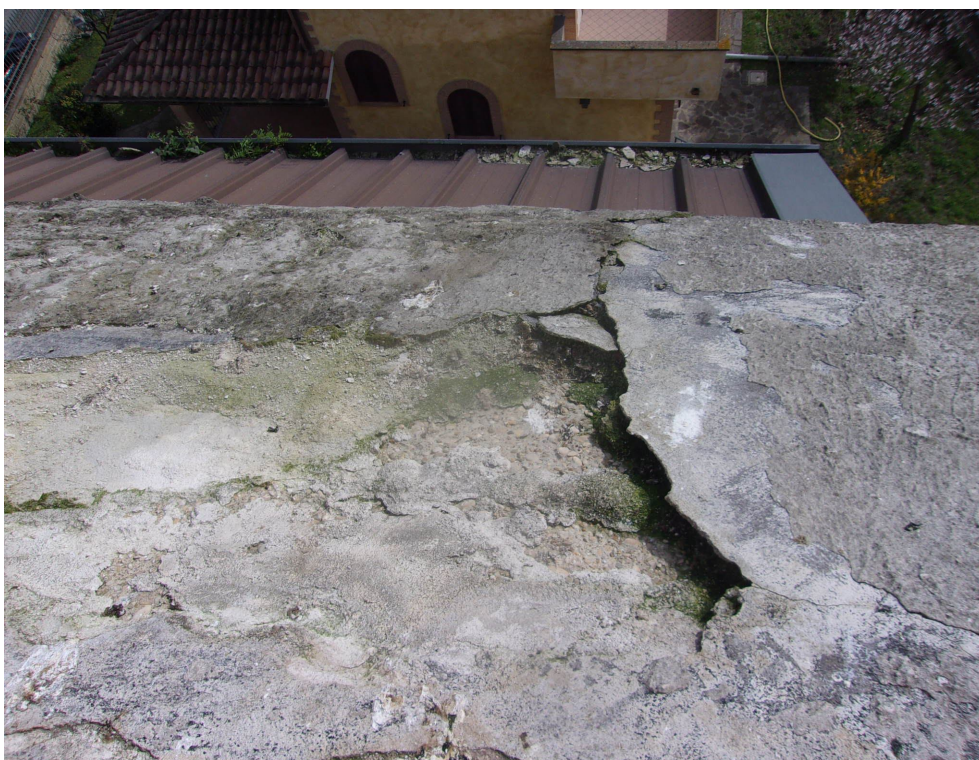
FOTO N. 14 Appartamento – Ripresa dal terrazzo sulla copertura del piano sottostante -
