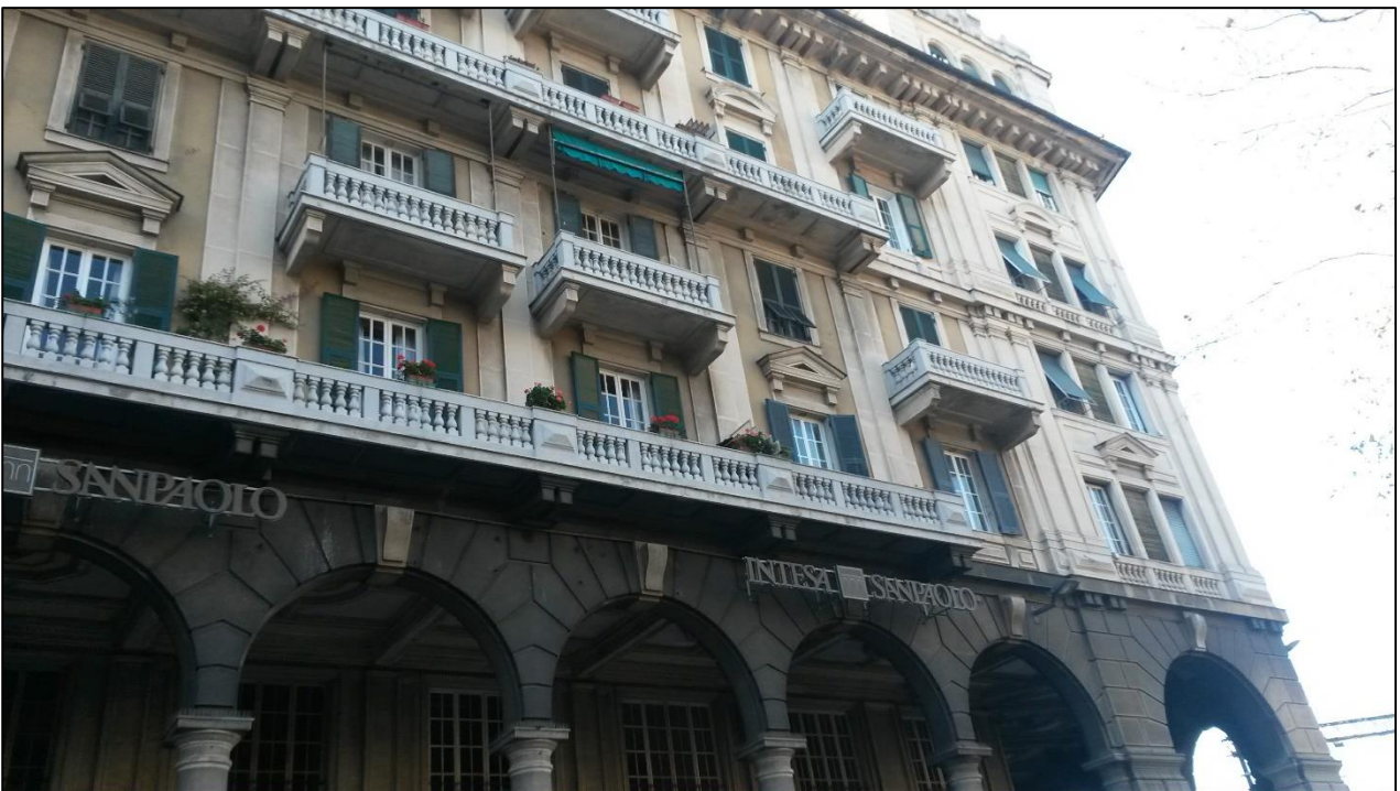
Figura 5 – facciata dell'edificio di cui l'unità è parte
