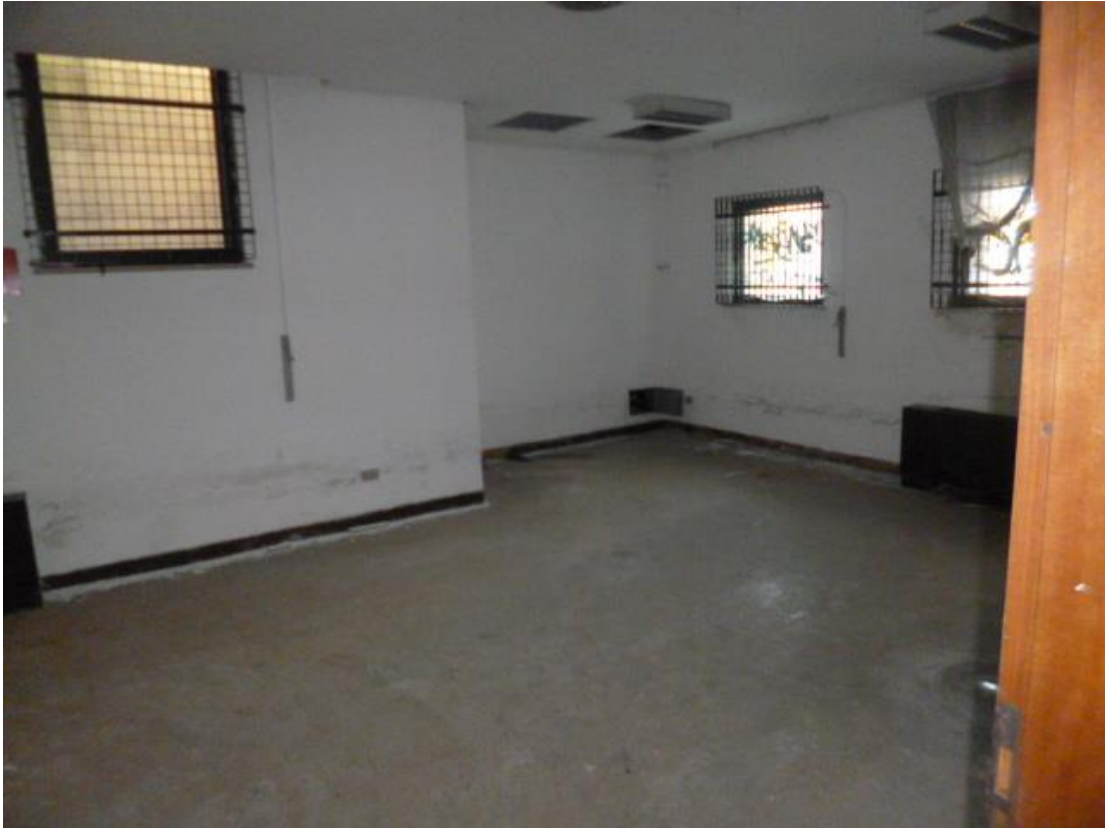
Figura 7 – spazi ad ufficio al piano terra (foto di repertorio)
