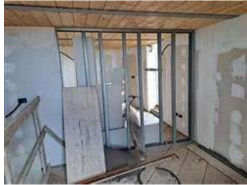
06.INTERNO LOCALE ACCESSORIO P.5 - SUB_15
