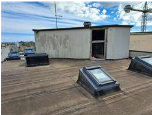
05.LOCALE ACCESSORIO P.5 (SOPPALCO) - SUB_14
