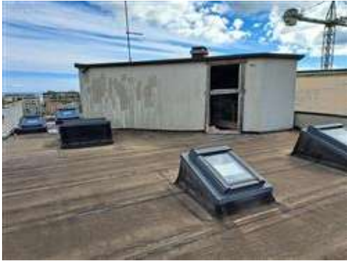
05.INGRESSO ESTERNO LOCALE ACCESSORIO P.5 (SOPPALCO) - SUB_15
