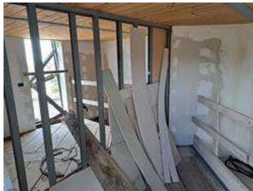
06.INTERNO LOCALE ACCESSORIO P.5 - SUB_14
