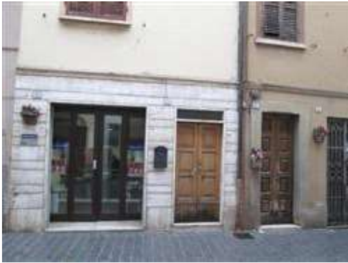
Prospetto su Corso Roma -Acqualagna
