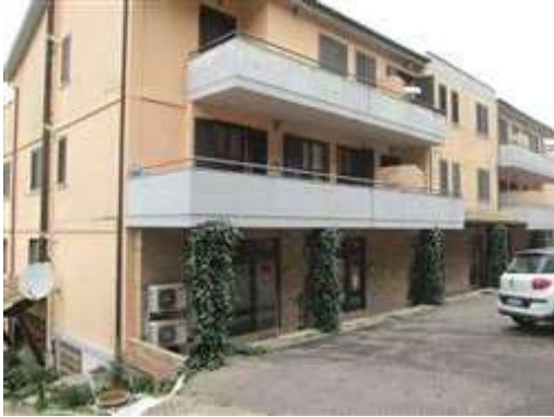
Fronte del palazzo ubicato in Via Don Minzoni,44 -Cagli
