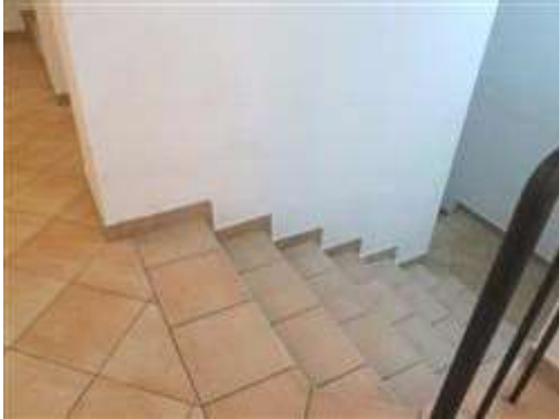
Scala interna condominiale -Fabbricato Cagli
