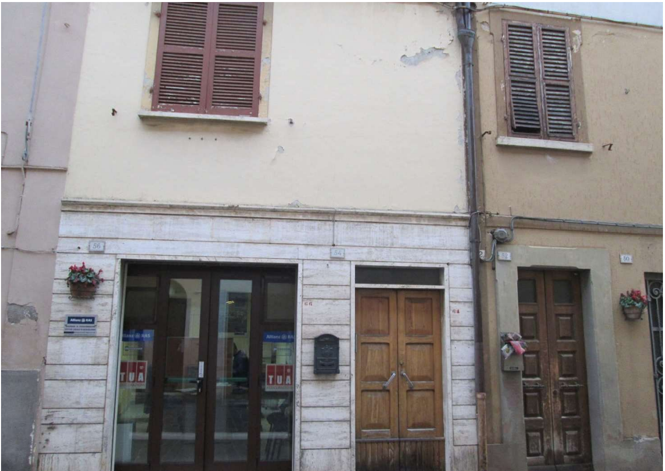
Foto 1- Prospetto su Corso Roma- vista dei due ingressi (civico54-56)
