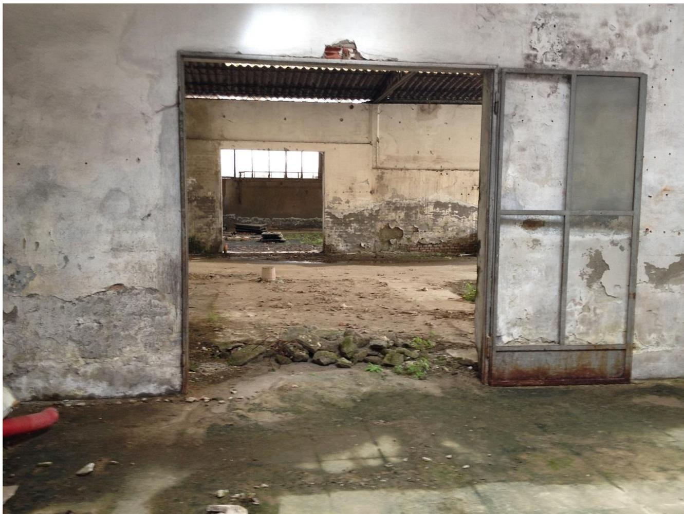
INTERNO CON PARTICOLARE “SAGGIO” PER ANALISI TERRENO
