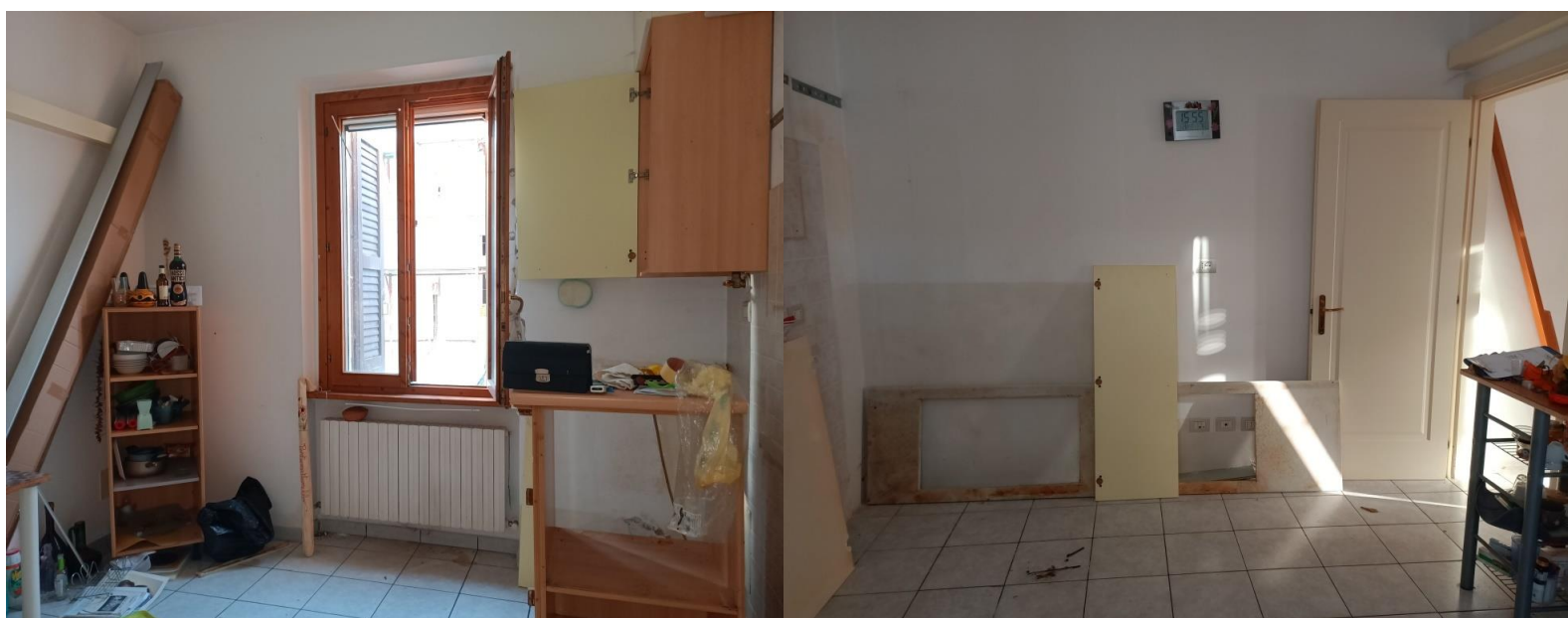
Viste della cucina piano terra direttamente comunicante con il soggiorno (In cucina è presenta la caldaia a gas metano, autonoma)
