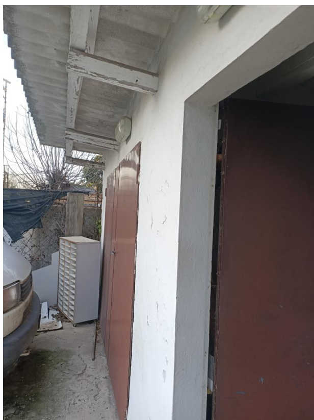
Facciata proservizi attuali con particolare copertura in lastre di cemento-amianto (Eternit) + Interno del locale destinato ad uso cantina
