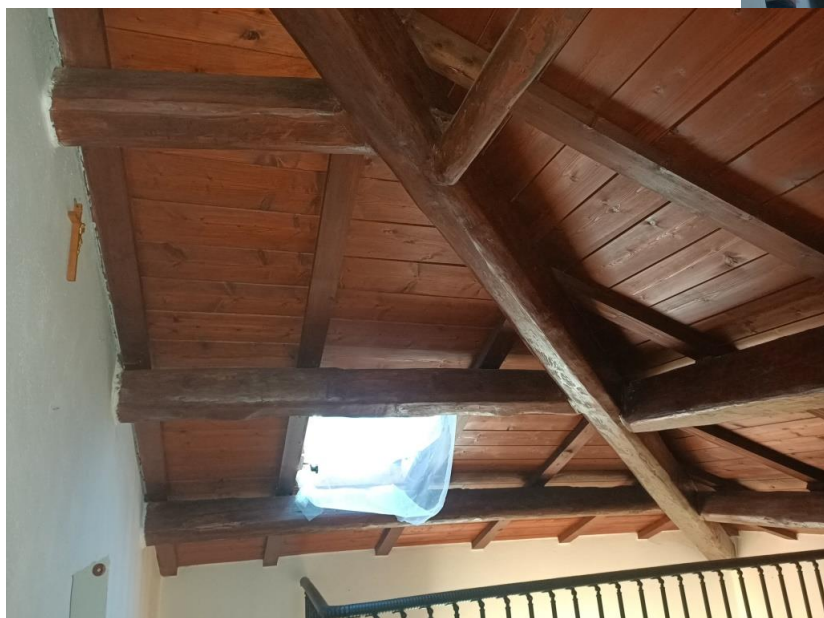
Zona del sottotetto vista nella porzione creata con un solaio orizzontale in legno (con affaccio sul guardaroba)
