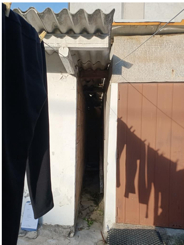
Fine degli attuali proservizi pignorati con copertura in lastre di cemento-amianto (Eternit) + particolare dello spazio vuoto di stacco da quelli a fianco, non oggetto di pignoramento
