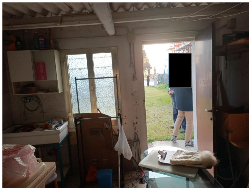
Interno attuale del locale destinato ad uso legnaia con vista delle aperture verso il cortile pertinenziale e particolare dotazione lavello e doccia a pavimento
