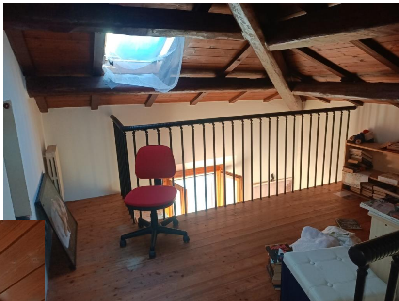
Zona del sottotetto vista nella porzione creata con un solaio orizzontale in legno (con affaccio sul guardaroba)
