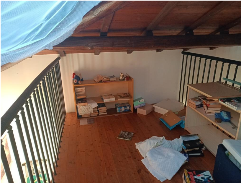
Sottotetto visto nella porzione creata con un solaio orizzontale in legno (con affaccio sul guardaroba e sulla scala) + Vista del punto di arrivo al sottotetto con apertura muraria di comunicazione diretta con altra porzione di sottotetto a quota di pavimento più alta di cm. 56 circa
