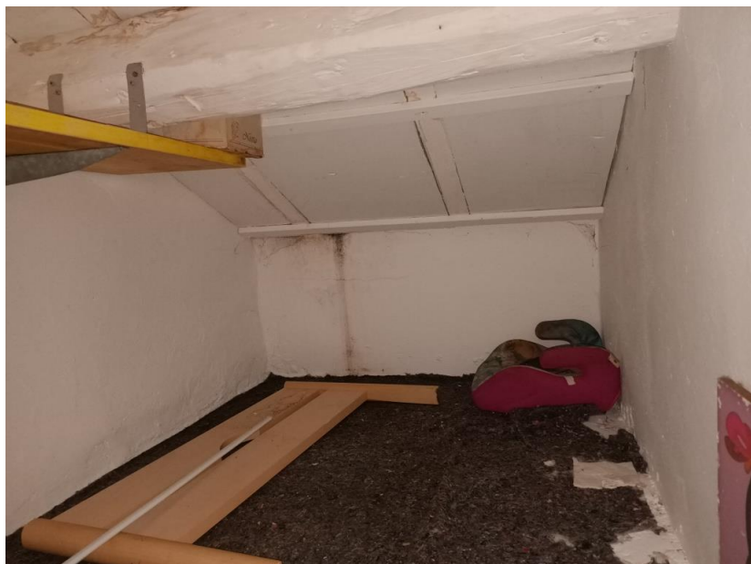
Piccola porzione di sottotetto (soprastante al bagno piano primo) con piano posto a quota più alta di cm.56 circa rispetto il solaio in legno orizzontale di arrivo dalla scala al sottotetto
