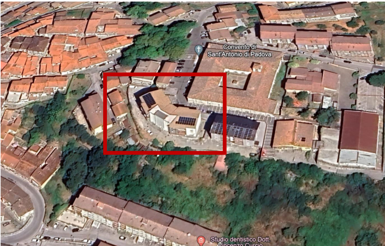
Figura 5 – Foto aerea con individuazione del complesso immobiliare.
