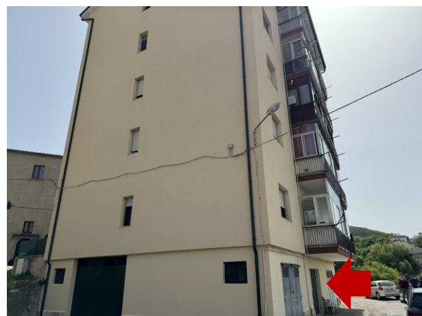
INGRESSO ALL'AUTORIMESSA AL PIANO S1 (C/6) - LOTTO UNICO – Lu.a
