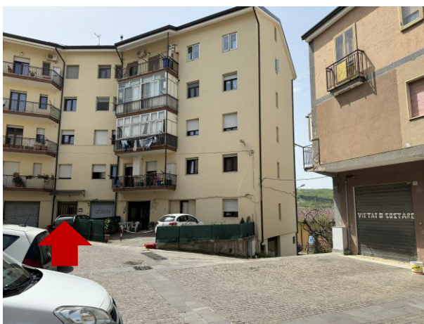
INGRESSO AL PIANO TERRA (C/2 E A/2) – LOTTO UNICO – Lu.b E Lu.c
