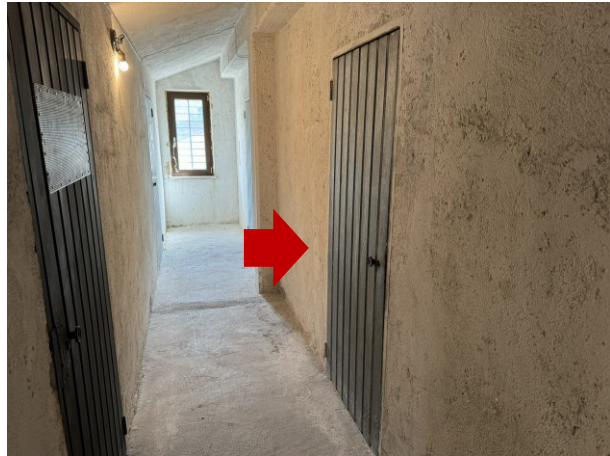
INGRESSO ALLA SOFFITTA DA PORTA INTERNA AL PIANO QUINTO - LOTTO UNICO – LU.c
