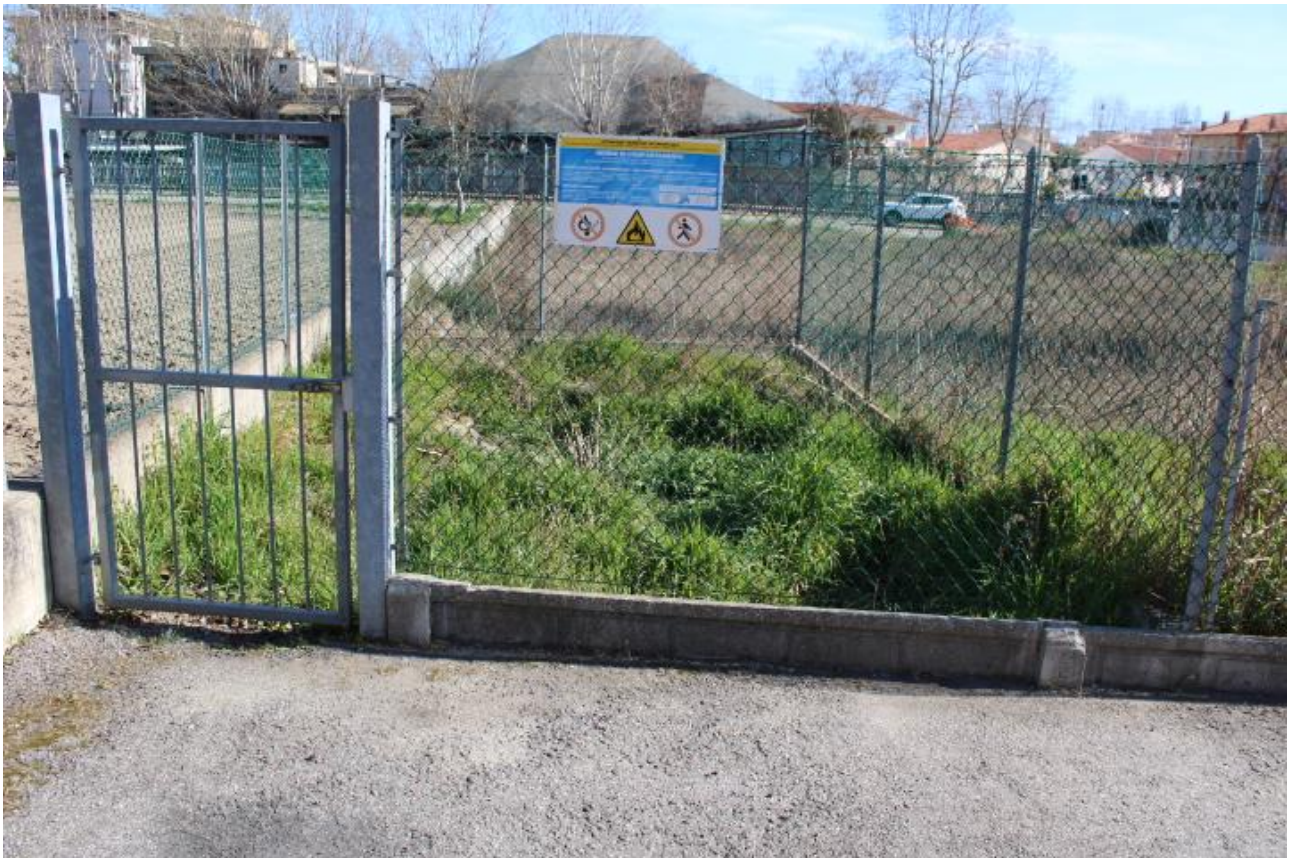
FOTO 5 – PORZIONE DI TERRENO RECINTATO CON SERBATOIO GPL INTERRATO, INSISTENTE SULLA PARTICELLA 2319
