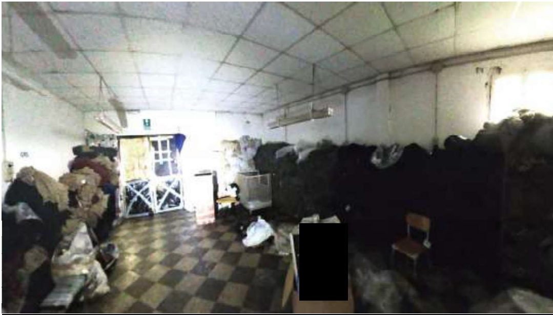
Figura 27 Interni magazzino adiacente al laboratorio
