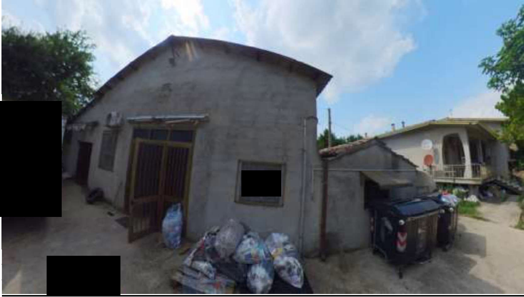
Figura 21 laboratorio lato Est
