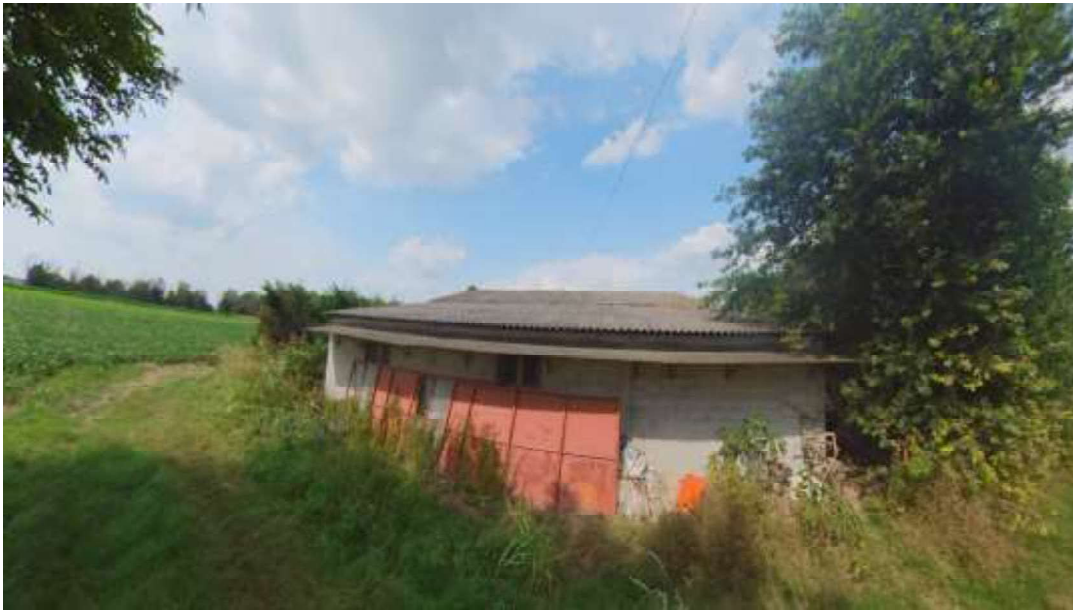
Figura 24 laboratorio lato Sud
