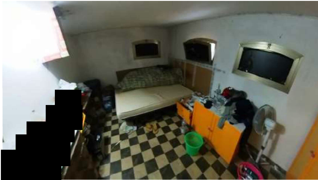
Figura 20 "cameretta" ricavata nella cantina seminterrato
