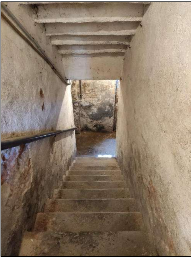
Scala di accesso alla cantina
