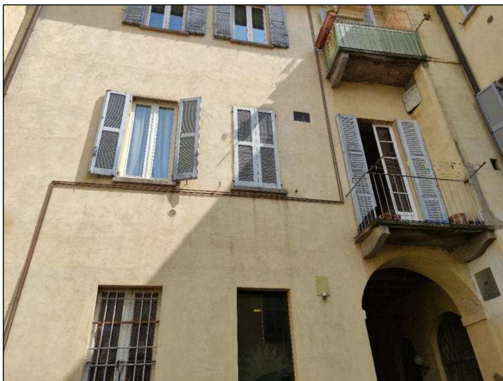
Prospetto su cortile interno
