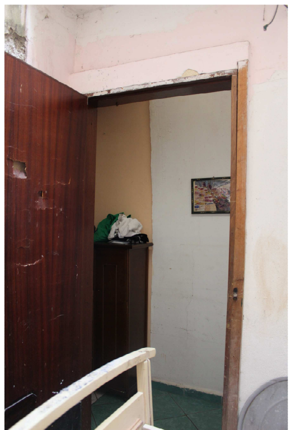
Foto n°10: Chiostrina (Vano b).
