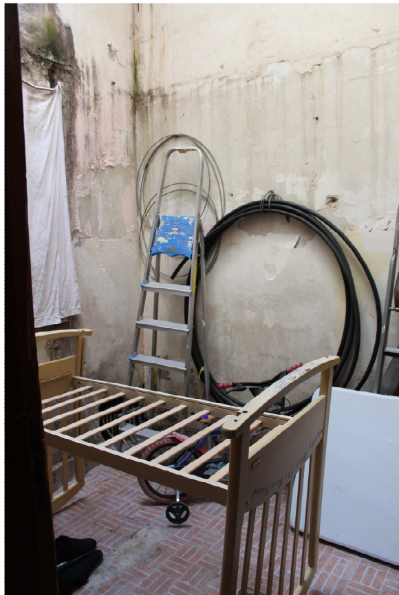
Foto n°9: Chiostrina (Vano b).
