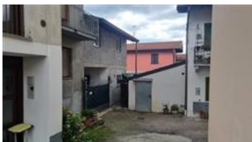
ingresso da strada
