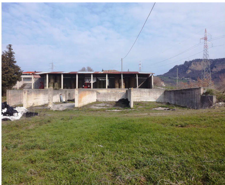
Foto n. 4 – il fienile ed i silos
