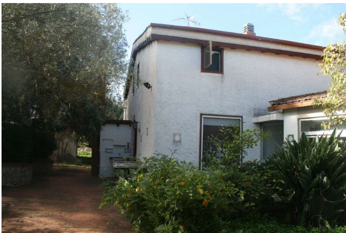
Foto n. 86: Fabbricato p.IIa 124 sub.1 – retro-prospetto
