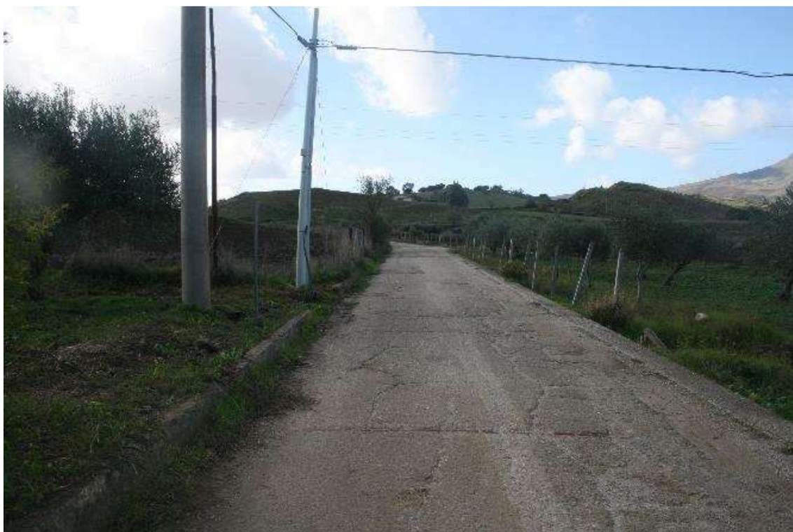
Foto n. 77: Contrada Piano individuazione della strada in cui sono ubicati i beni
