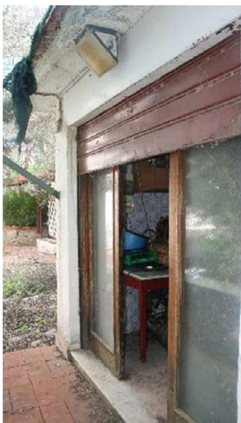
Foto n. 136: immobile sub 3 - cucina
