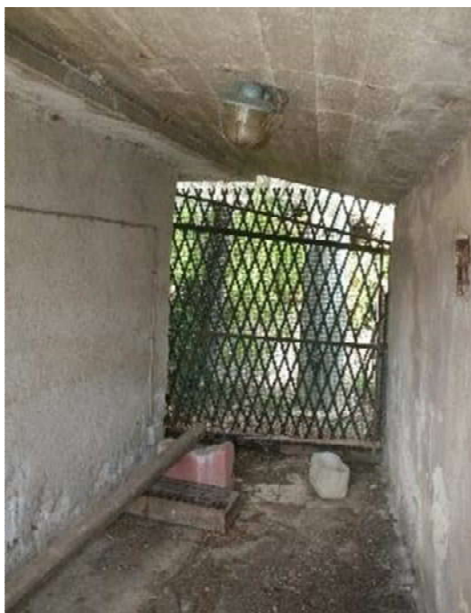
Foto n. 140: varco accesso pollaio
