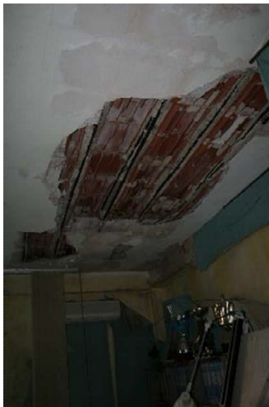
Foto n. 73: ammaloramento solaio
