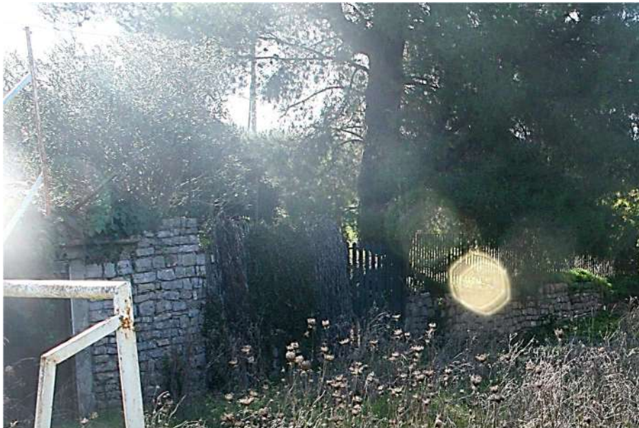
Foto n. 145: vista esterna della cantina - part.IIa 213
