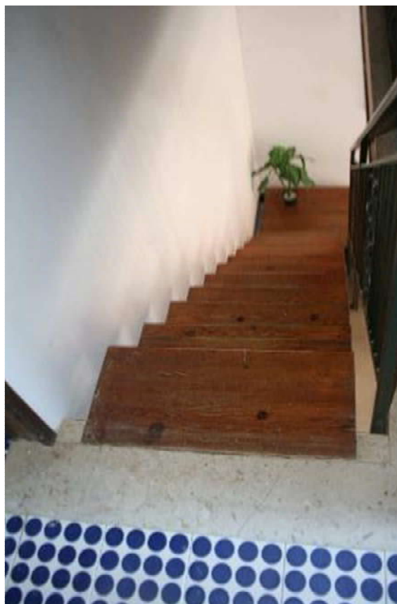
Foto n. 106: corpo scala dal corridoio
