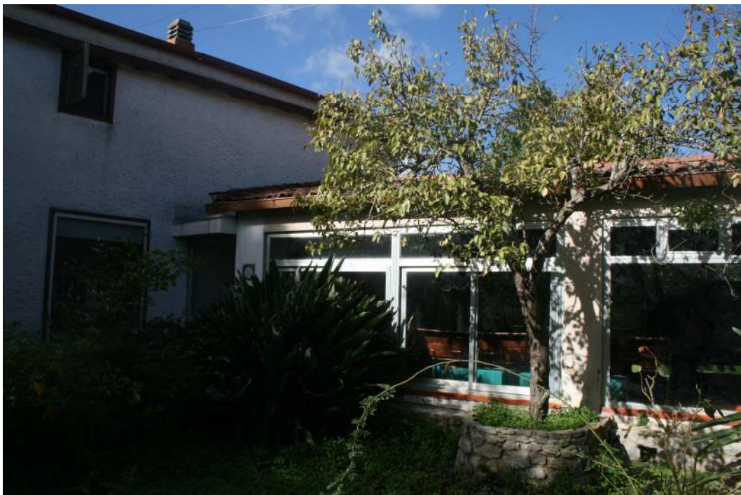
Foto n. 125: sub 2 – veranda, prospetto sud/est
