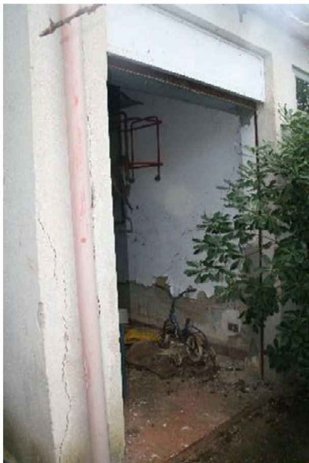
Foto n.131: ingresso al magazzino
