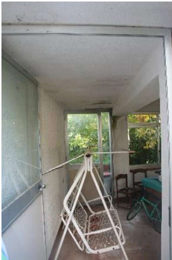
Foto n. 129: porzione di veranda annessa alla villa
