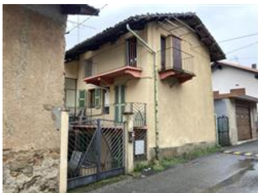
Prospetto su via Chiaberge
