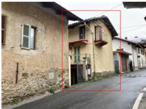
Vista generale a valle di via Chiaberge
