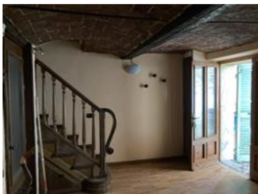
Locale interno piano terra
