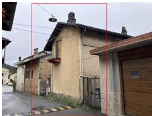
Vista generale a monte di via Chiaberge
