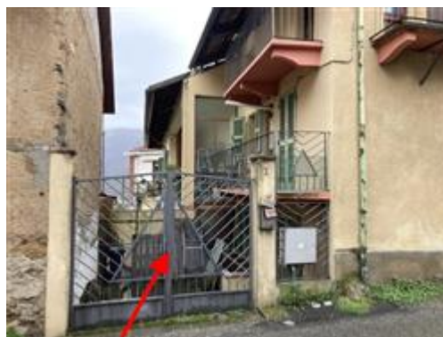
Particolare ingresso e cortile pertinenziale
