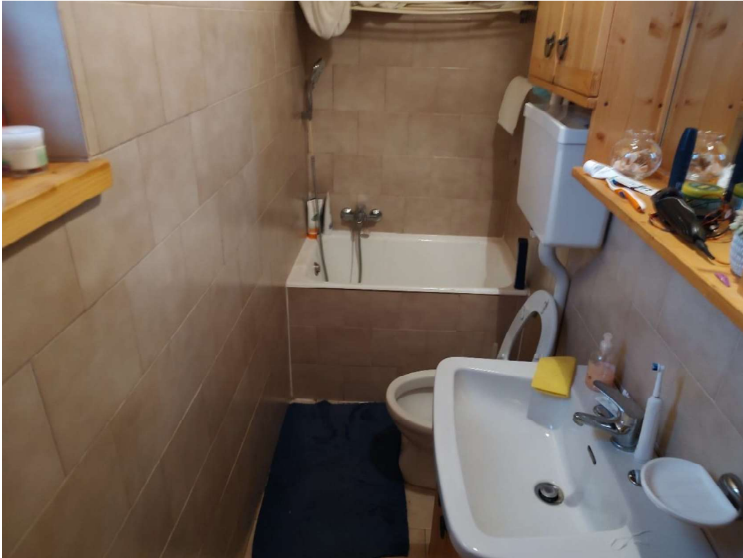
Angusto servizio igienico dell'unità di cui al punto B della relazione
