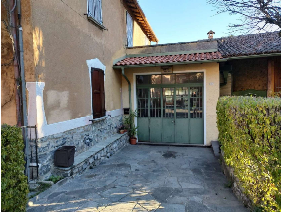
Portone in ferro di accesso all'unità laboratorio di cui al punto A della relazione
