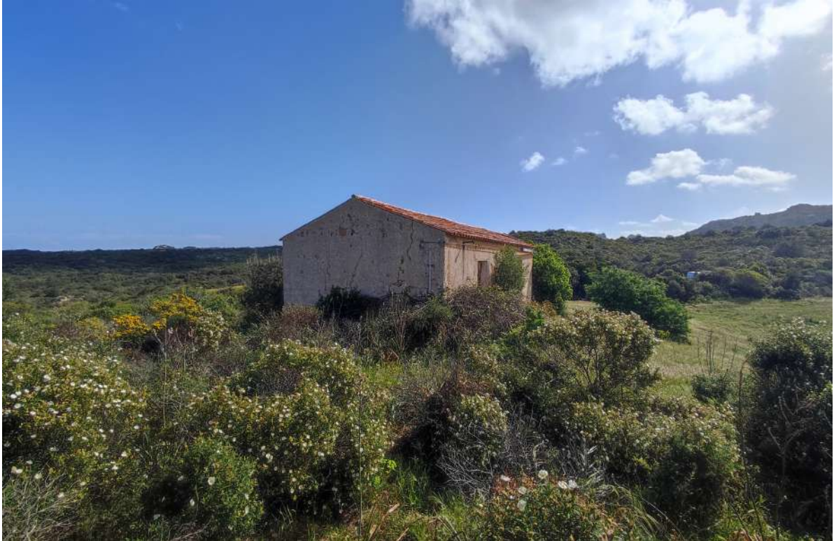
Scorcio del fabbricato distinto al Mapp. 312. Vista da sud-ovest.
