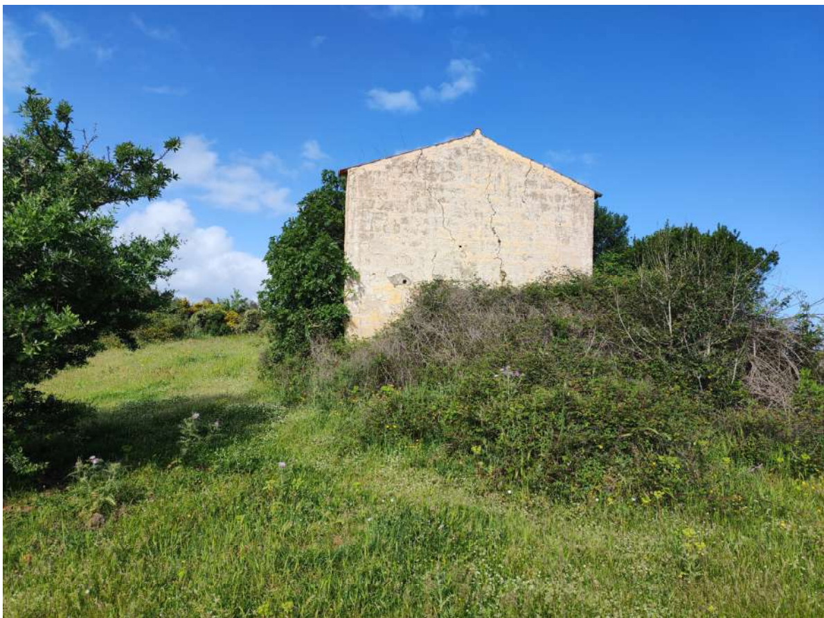
Scorcio del fabbricato distinto al Mapp. 312. Vista da est.
