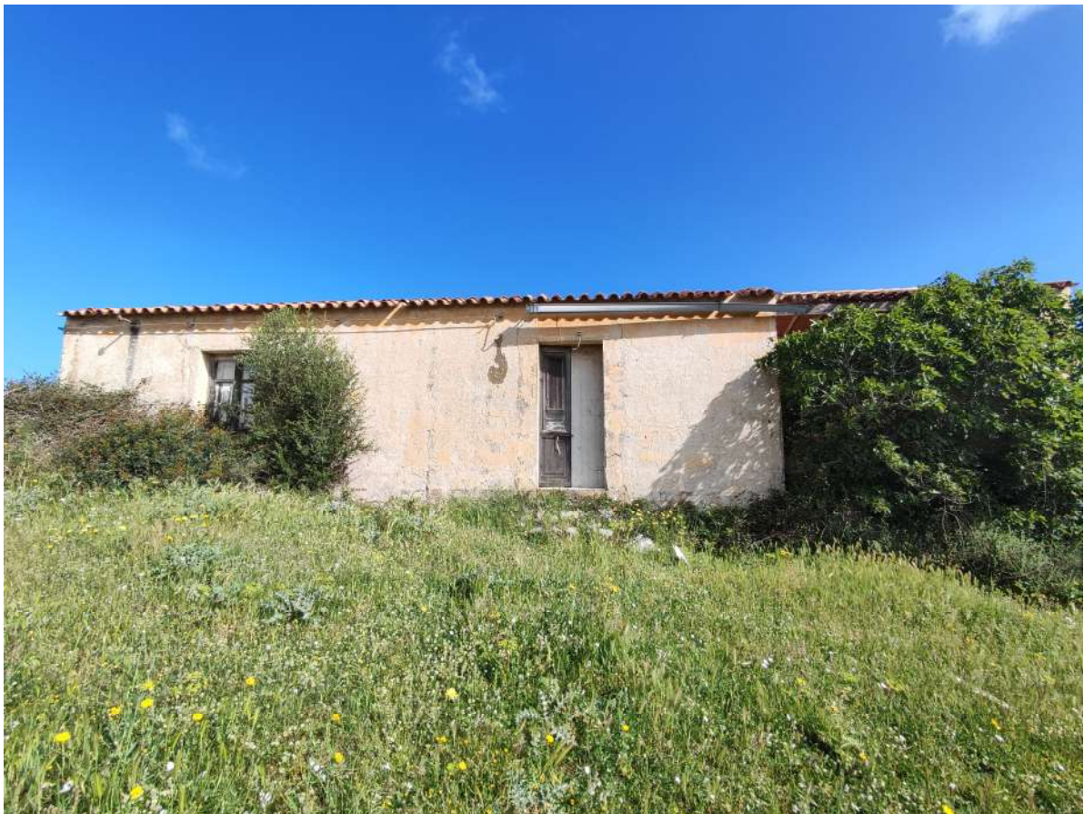
Prospetto principale del fabbricato distinto al NCEU al F.7 Particella 312.
