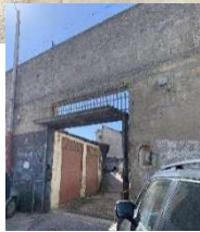
Vista dei 9 BOX Sub. 29
