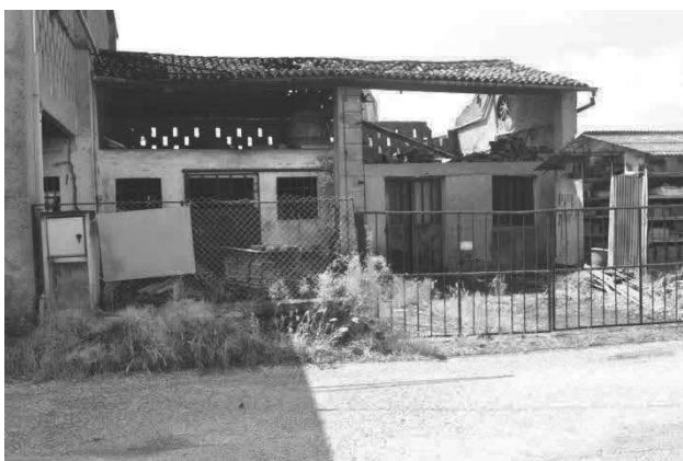
foto 4 - scorcio dell'ex stalla d'epoca sull'estremità ovest del m.n. 557 ridossata a ovest del complesso stalla/portico/fienile realizzato nel 1960: sono evidenti le pessime condizioni del vecchio edificio collabente ora allibrato come deposito con coperture e solai privi di tenuta e pericolanti
