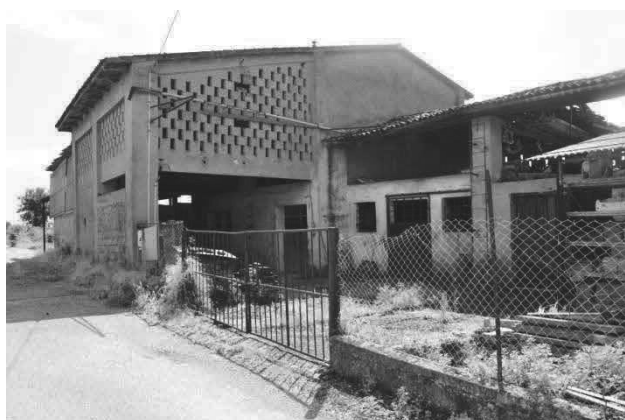
foto 2 - vista da nord ovest dell'ex stalla d'epoca (a destra nella foto) e dell'ex complesso stalla/portico/fienile (al centro/sinistra nella foto) in località Le Ché, entrambi a due piani f. t. con la relativa pertinenza m.n. 557 in parte recintata con accessi provenienti dalla corte comune (m.n. 82) - nella parte est del lotto (a sinistra della foto) s'intravede la sequenza iniziale delle tettoie
