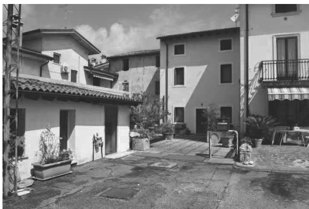
foto 1 - vista da sud est dell'abitazione a tre piani f. t. al civ. 11 in località Le Ché (al centro in secondo piano nella foto) con la relativa pertinenza pavimentata dove è stato realizzato lo scantinato dell'abitazione e col deposito /c.t. (m.n. 682) a sinistra della foto con accesso pedonale/carraio dalla corte comune (m.n. 82) in primo piano
