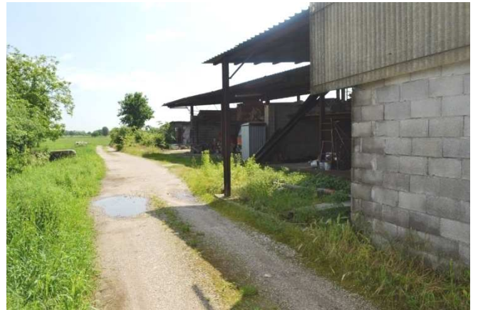
foto 11 - Vista della parte centrale delle tettoie a est
