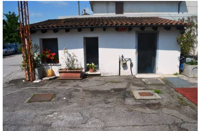
foto 6 - Vista da sud est del deposito/c.t. sul m.n. 684
