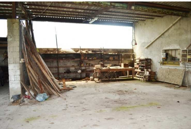
foto 30 - Vista da nord della tettoia centrale
