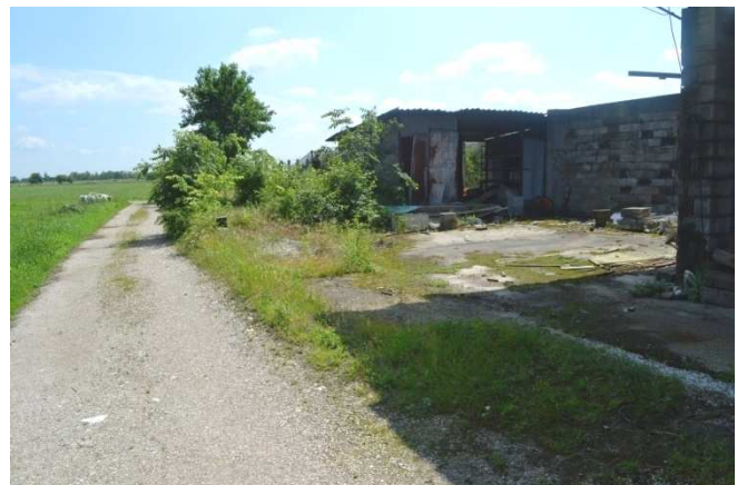
foto 13 - Vista da ovest della parte est delle tettoie
