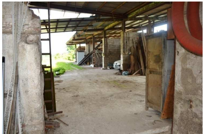
foto 31 - Vista da ovest delle tettoie a est dei magazzini
