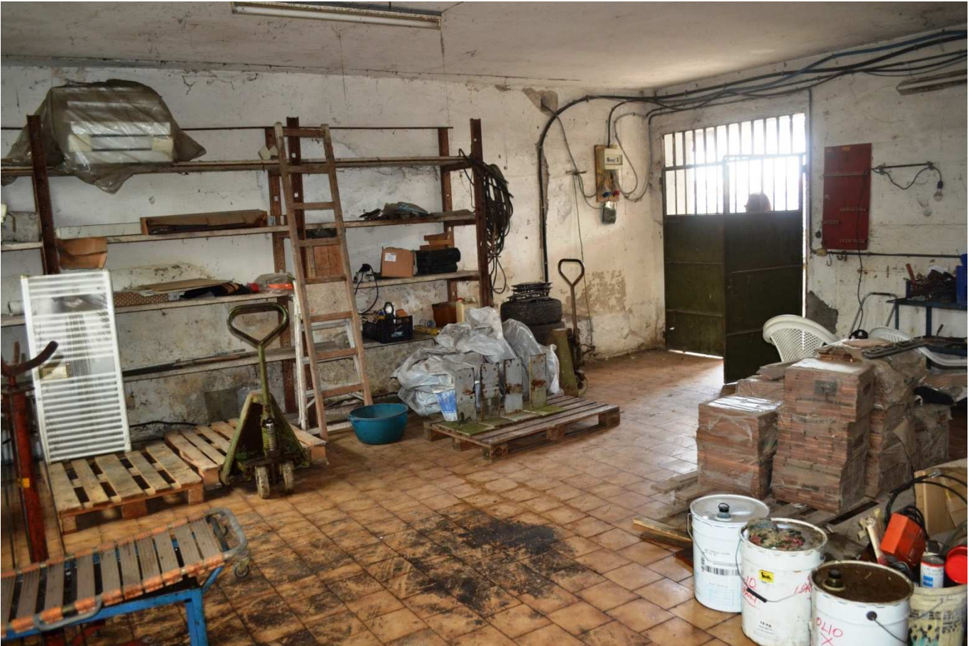
foto 29 – Magazzini/depositi in località Le Ché, piano terra, ex magazzini impresa edile - parte centrale
