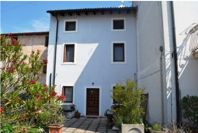
foto 5 - Scorcio del prospetto sud dell'abitazione
