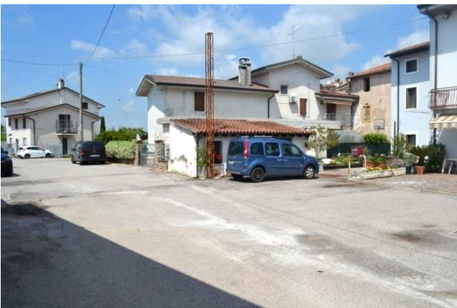
foto 7 - Vista da est della pertinenza pubblica m.n. 82
