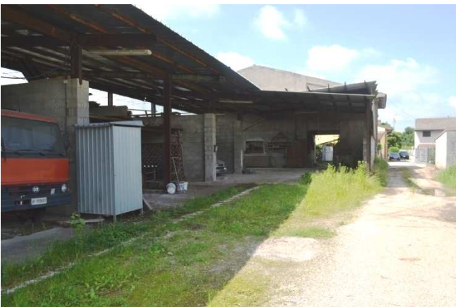
foto 12 - Vista da est della parte centrale delle tettoie
