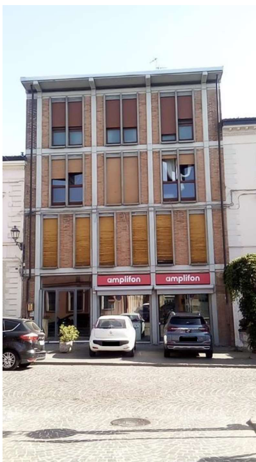
Figura 11 : Esterno 2 - Prospetto Ovest – fronte principale Vista Largo Antonio Gramsci
