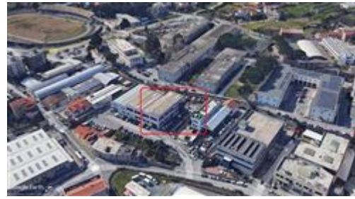
Fabbricato a destinazione produttiva via Molinero 9r vista generale
