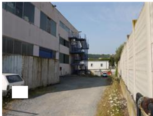
Vista corte pertinenziale
