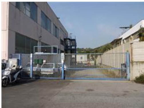
Vista varco di accesso alla corte pertinenziale
